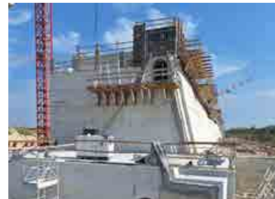
Realizzazione del manufatto A
