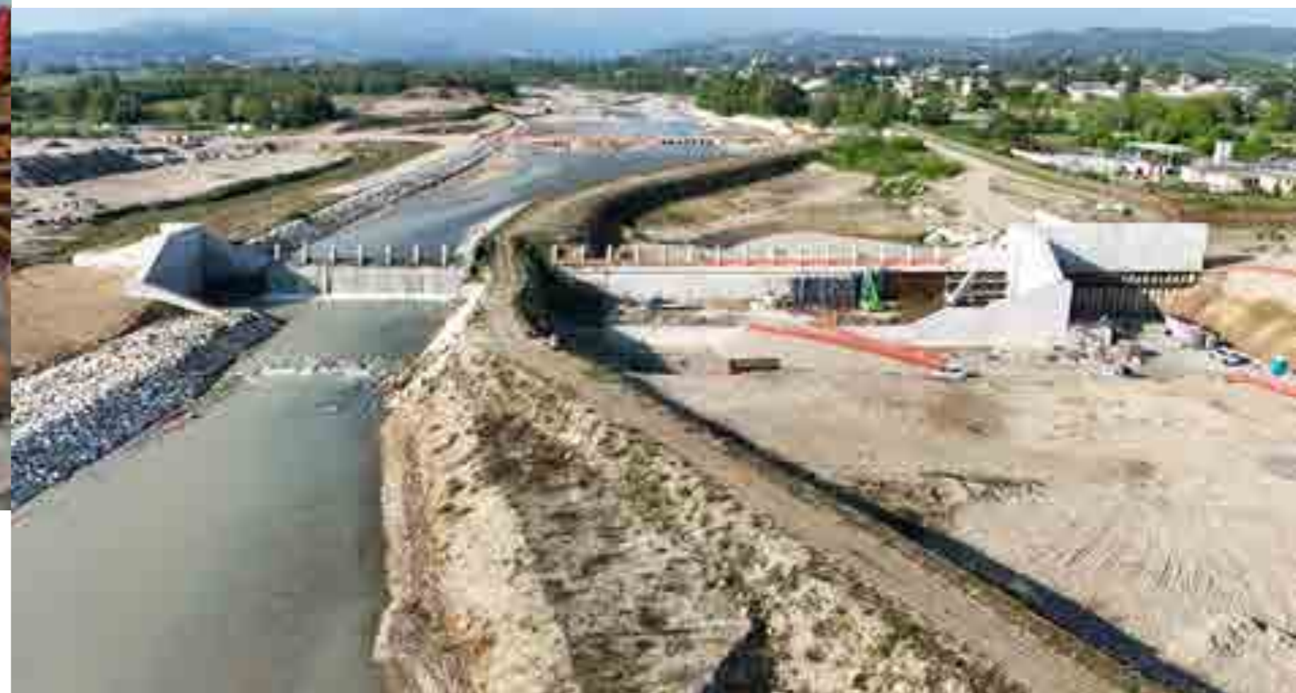
Fase di costruzione della briglia selettiva di monte
