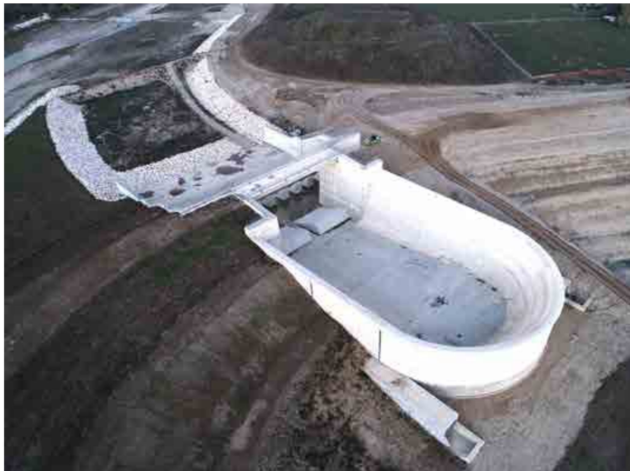
Manufatto C della cassa di espansione del torrente Baganza, novembre 2025
