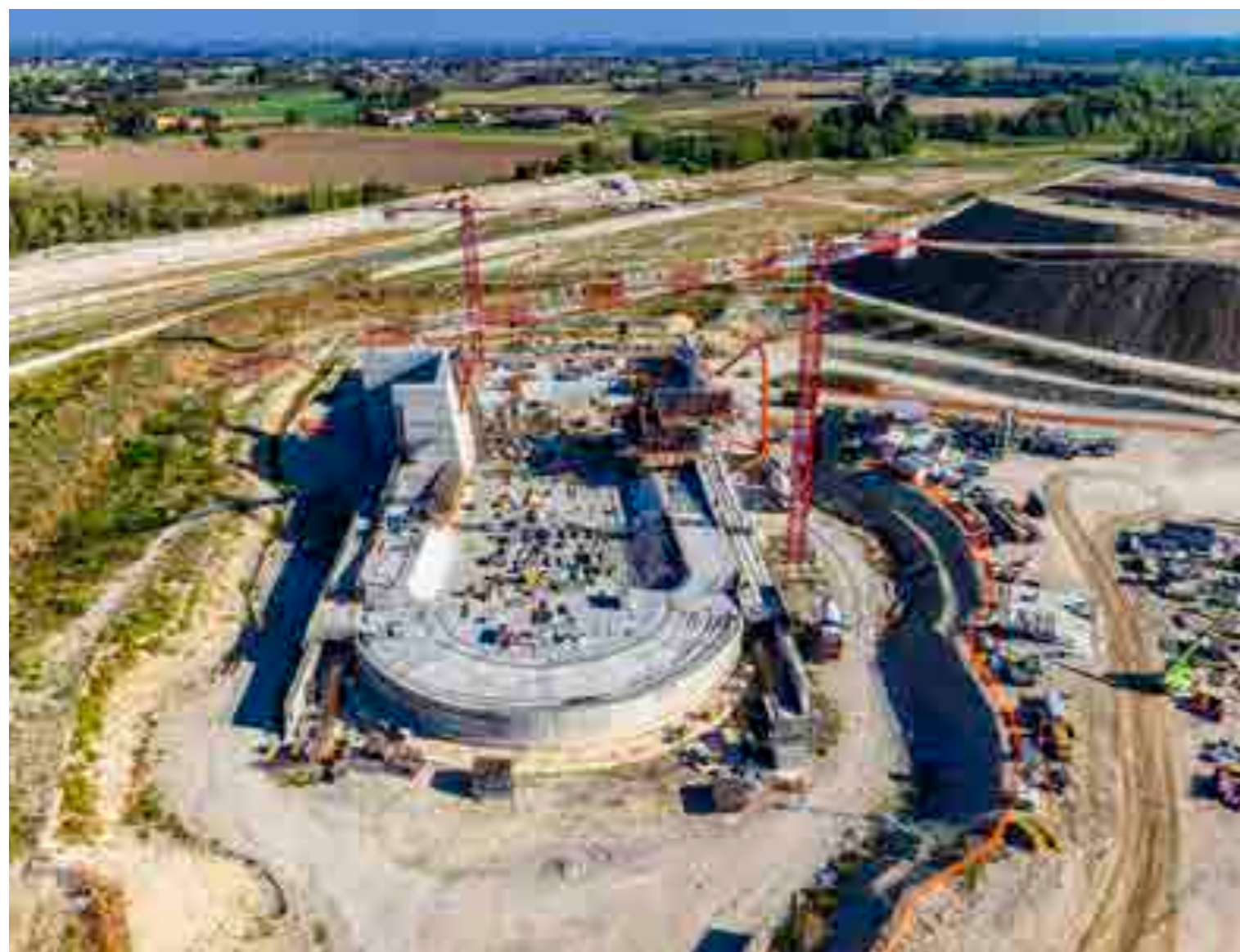
Fase di elevazione del manufatto C
