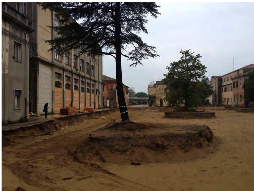
Fig. 8 - 04.03.2013 Giorno di chiusura del Cantiere di bonifica. Vista sullo scavo con facciata sud-ovest del Teatro Marinoni. Foto di Giulia Mazzorin
