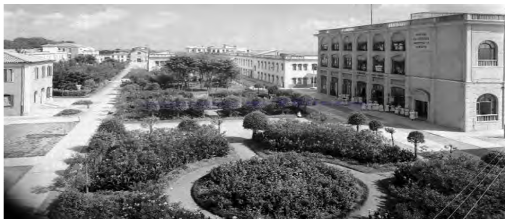
Fig. 5 - Ospedale al Mare, panoramica degli edifici, 1938/09, Archivio Giacomelli, Arcipelago sanitario lagunare, scheda n. 45040, fondo Reale Fotografia Giacomelli, proprietà del Comune di Venezia.
