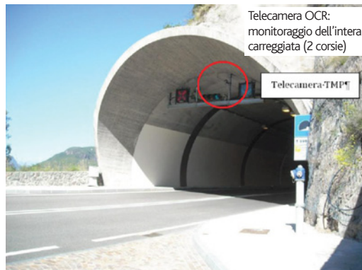
Figura 4 – Esempio di gate installato in galleria.
