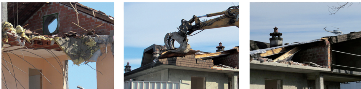
Figura 3 – Attività di demolizione
