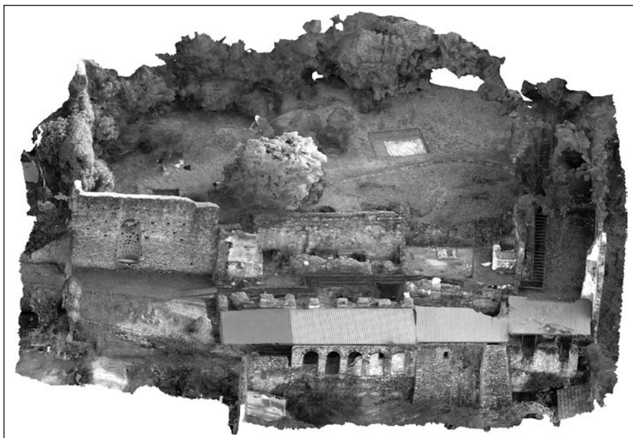
Fig. 16 – Frame della modellizzazione 3D del sito tramite riprese da drone.
