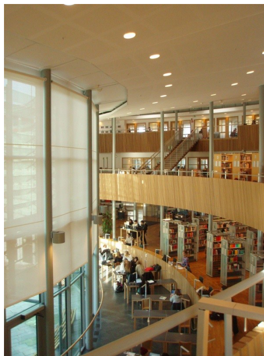
Figura 11: l'utilizzo di un sistema di supervisione per la gestione integrata di schermature, illuminazione naturale e artificiale è fondamentale per la riduzione dei consumi elettrici.
