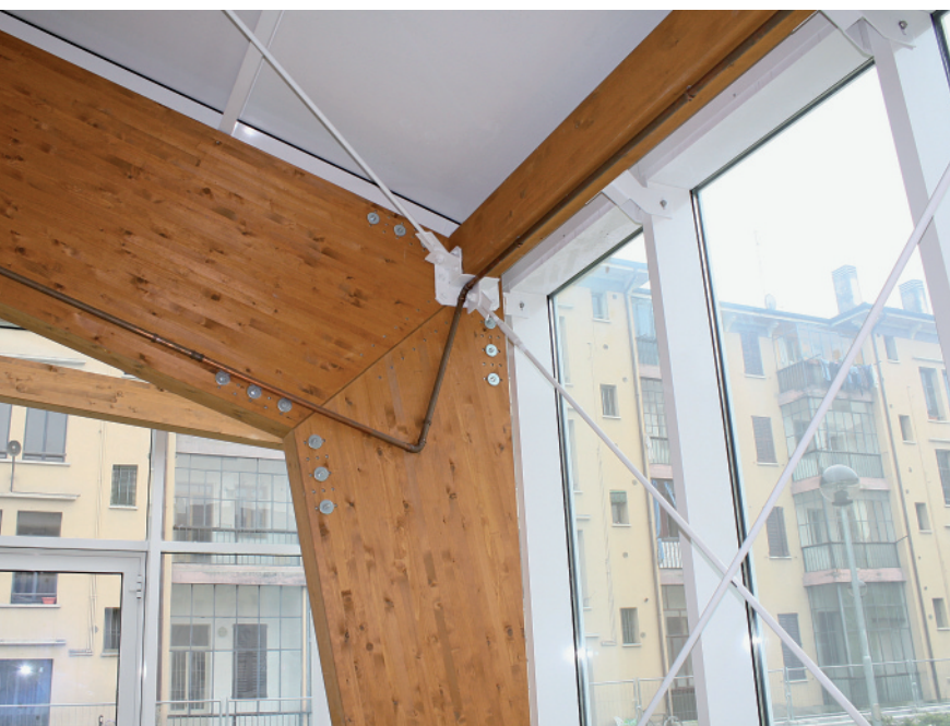
7. Interfacce tra struttura principale e intelaiatura esterna, secondo la connessione esercitata dai perni collegati ai correnti in legno lamellare
