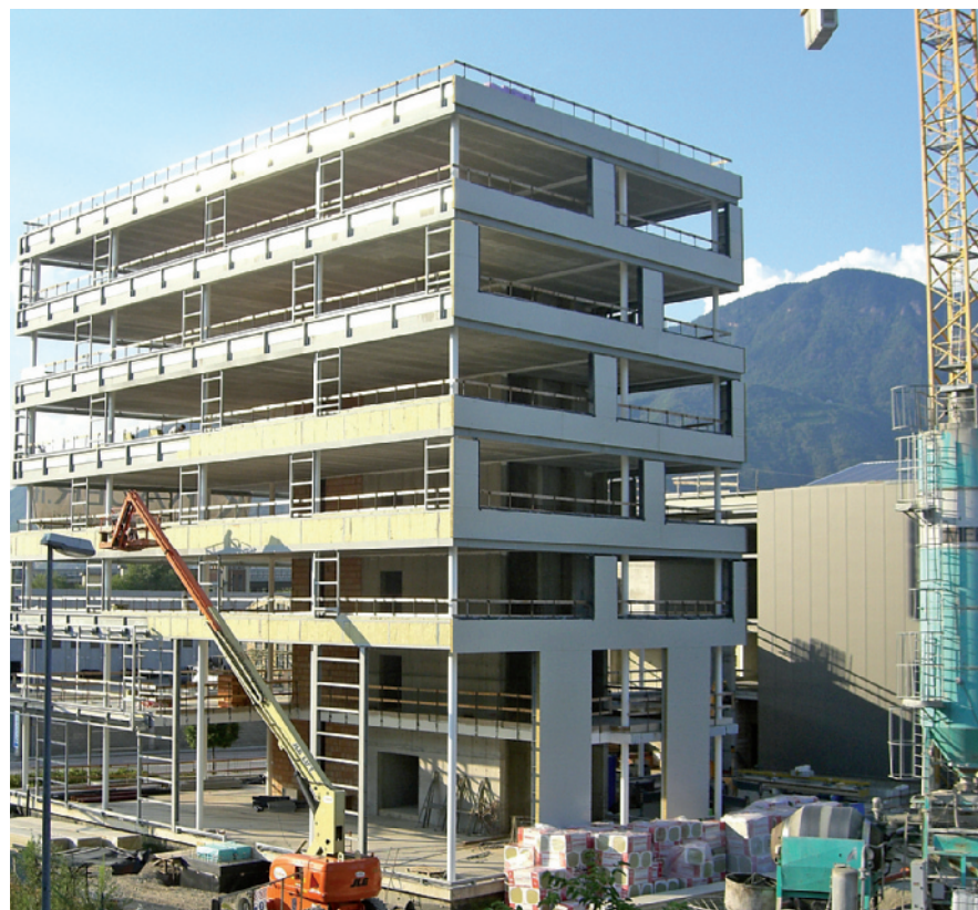
2. Esecuzione dei sistemi di involucro: assemblaggio all'orditura dei pilastri in acciaio, alle mensole e alle travature di bordo
