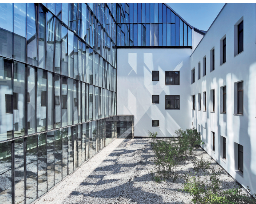
Confronto morfologico e costruttivo tra il settore preesistente riqualificato e il settore di nuova edificazione, secondo l'espressione della corte "verde"
