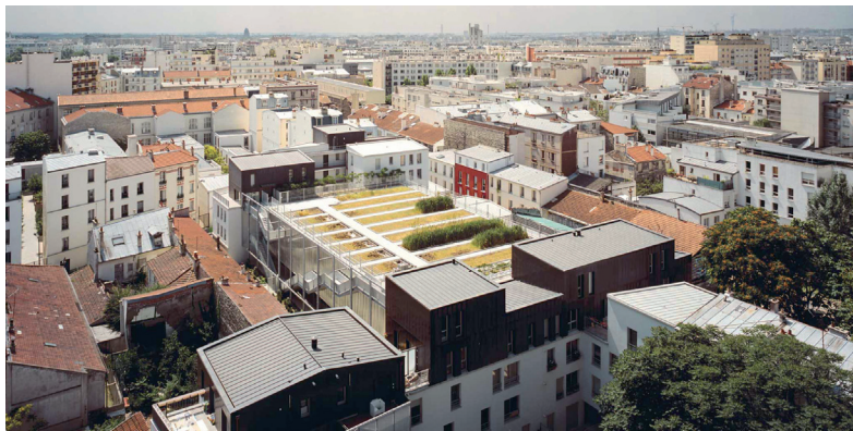
TOA, Logements, gymnase et jardin associatif , Paris, 2003-08
