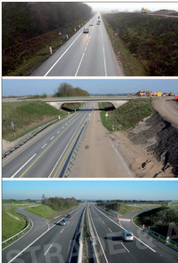
Figura 2 - I lavori di adeguamento sulla A20 iniziati nell'anno 2008
