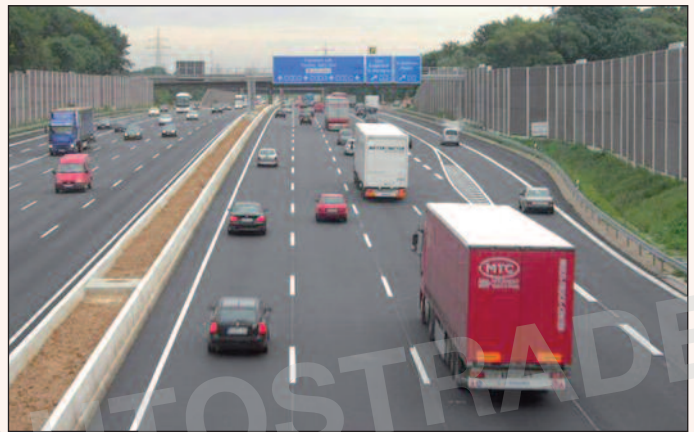
Figure 6A e 6B - I lavori di adeguamento della A2 iniziati nell'anno 2012
