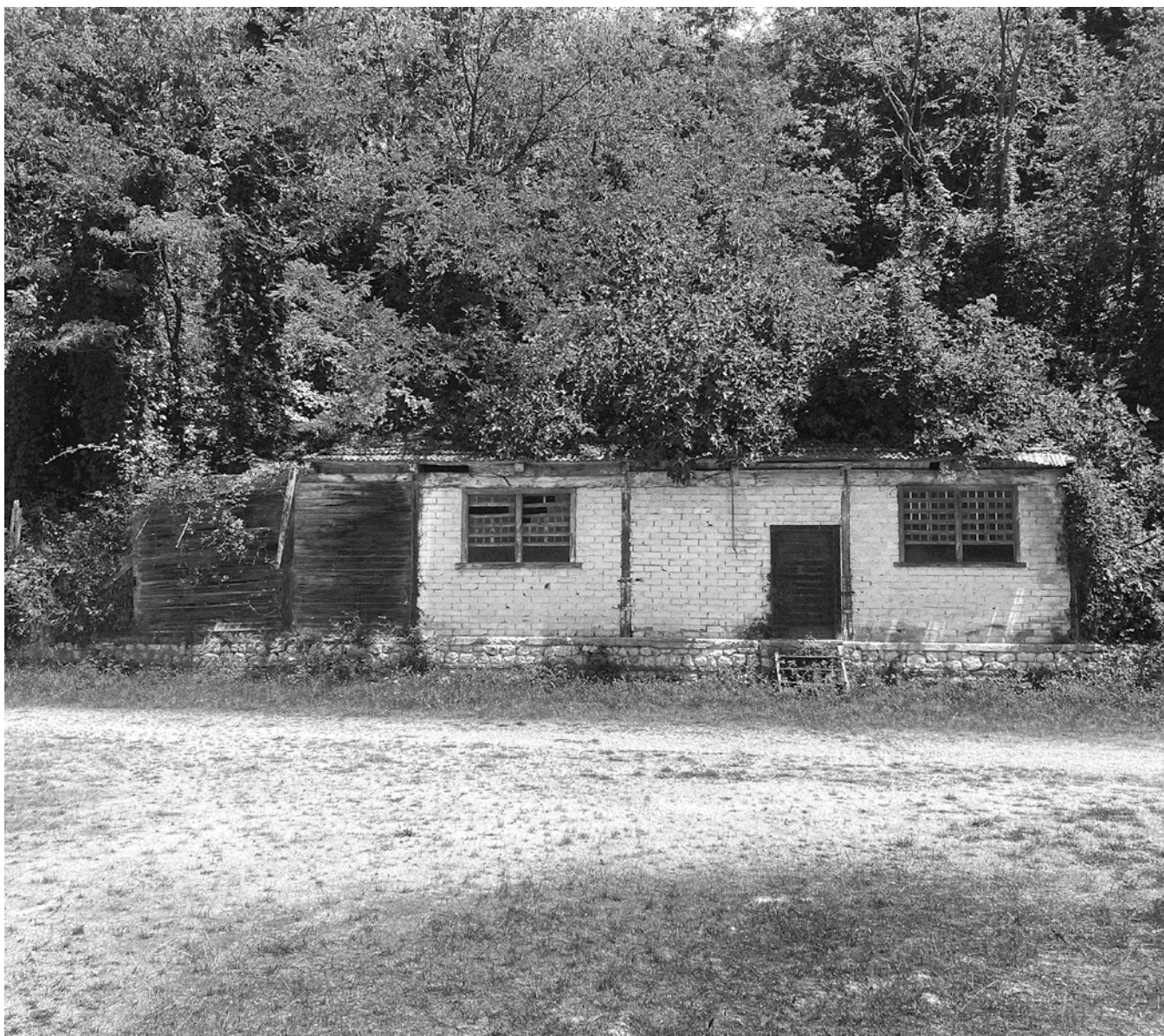
01. Ex magazzino presso la centrale Torlonia di Canistro | Former warehouse at the Torlonia power station in Canistro. G. Azzini
