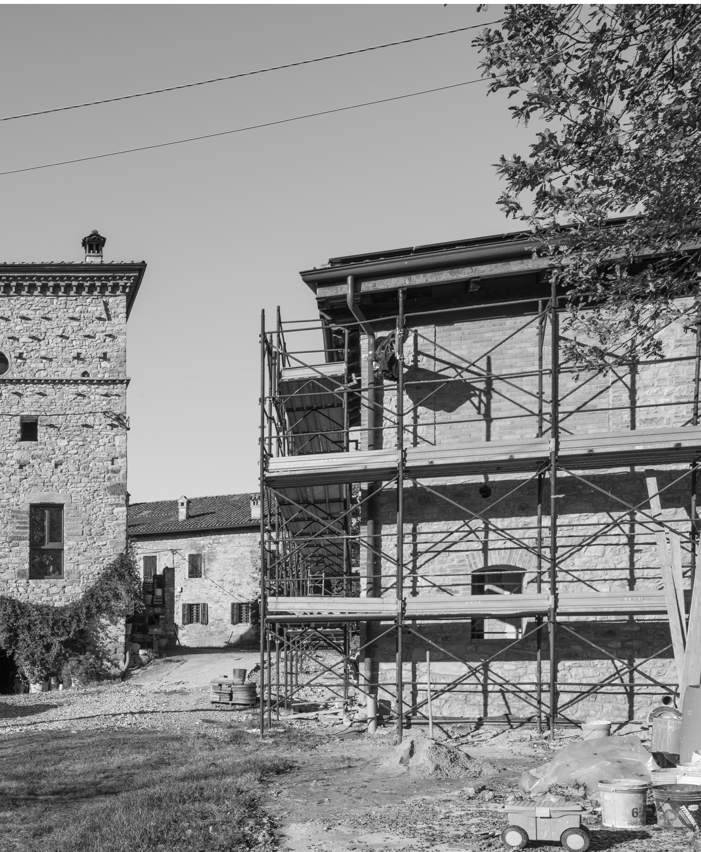
Casa torre di Ca' de Grassi e cantiere PNRR - Restauro e valorizzazione del patrimonio architettonico e paesaggistico rurale. Ph. Giacomo Albo, 2024
