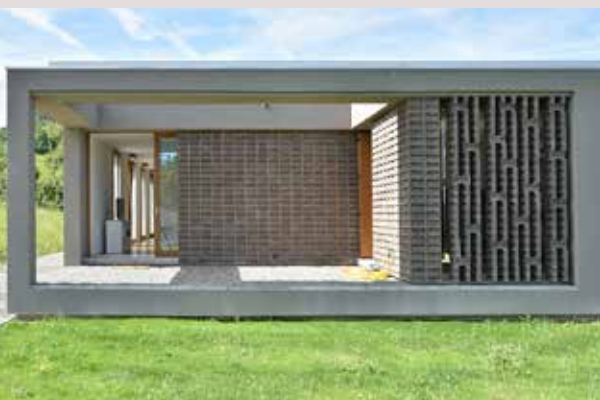
Vista frontale della facciata nord nel punto di ingresso all'edificio.
