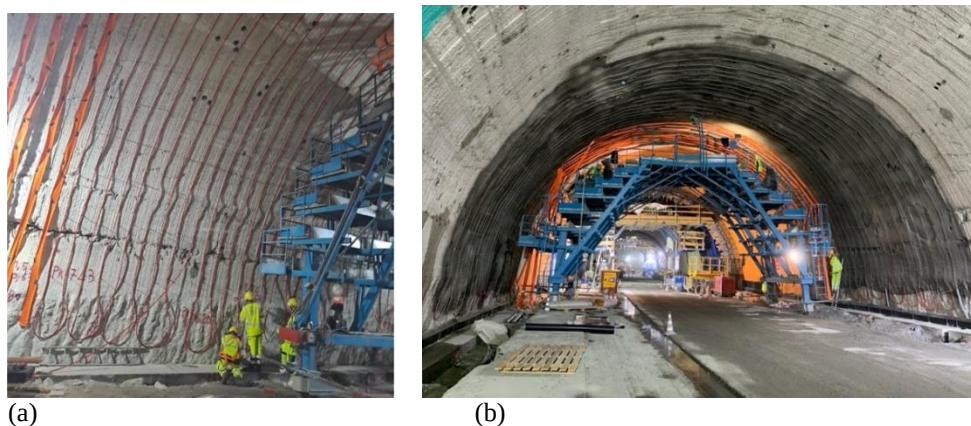
Figura 3. Esempio di attivazione termica di una galleria esistente: (a) fissaggio delle tubazioni geotermiche sull'intradosso fresato e (b) posizionamento del manto impermeabilizzante a contatto con lo strato di regolarizzazione nel quale sono annegate le tubazioni (Politecnico di Torino, 2024).
