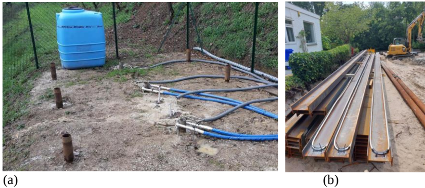
Figura 1. Esempio di (a) micropali energetici presso l'Università di Perugia (Ronchi et al. 2018), (b) applicazione di diaframmi CSM energetici ad Amstelveen (Leclercq et al., 2023, Gerola et al., 2024b).
