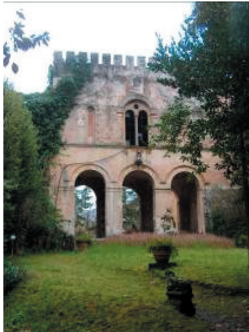
Figure 4: Southern part of the Palazzina dell'Orologio
