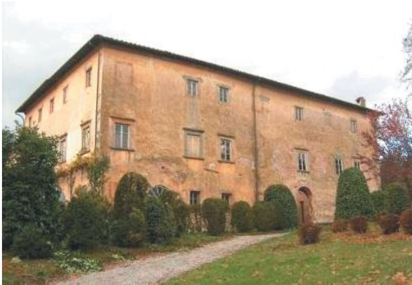
Figure 3: Villa del Vescovo, western façade
