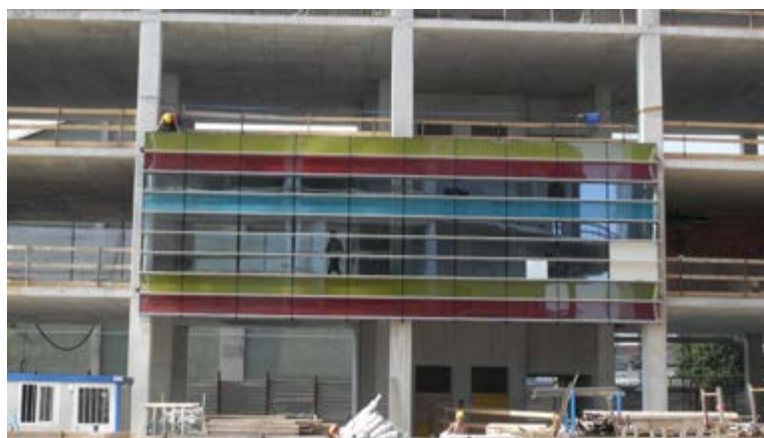
4 Procedura di simulazione e di anticipazione per la verifica delle sequenze costruttive di assemblaggio dei moduli di facciata (Giancarlo Marzorati Architetto, Colour Building, Milano)
