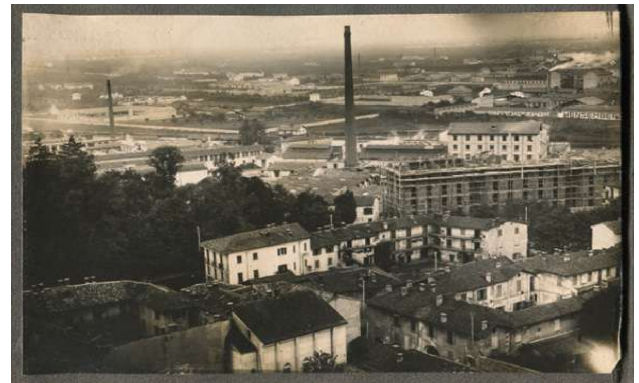
Fig. 5 - Vista di un comparto industriale monzese ed edificato diffuso (Archivio storico, Comune di Monza).
