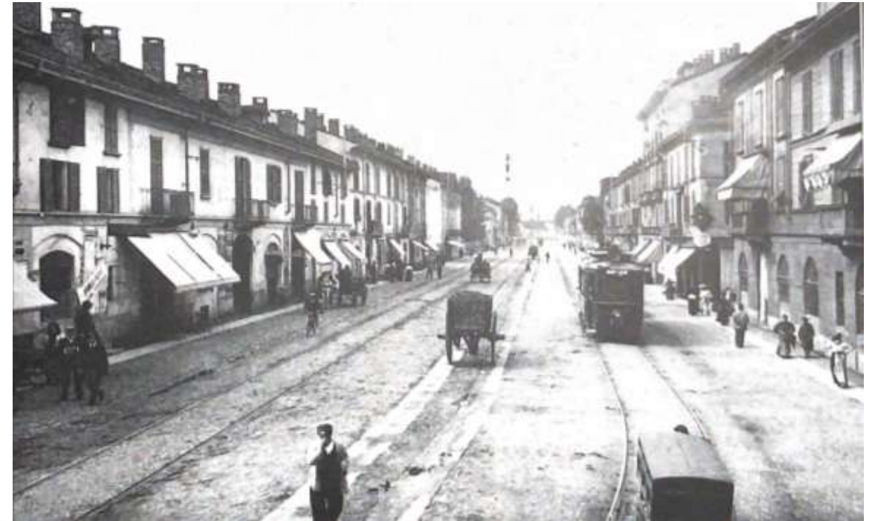
Fig. 6 - Corso Milano verso la fine del XIX secolo (Archivio storico, Comune di Monza).
