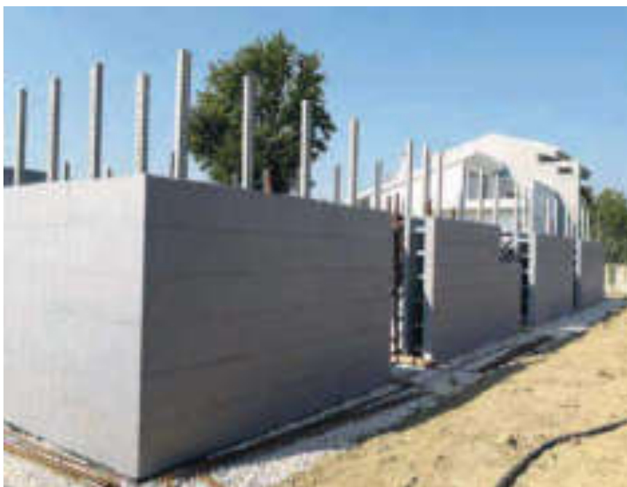
Fig. 7.35: Pareti realizzate con il sistema costruttivo Bioisotherm - Argisol. Fonte: Bioisotherm S.r.l.
