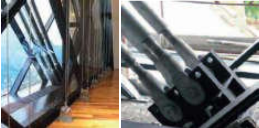
Fig. 7.72: A sinistra particolare della facciata caratterizzata da una doppia pelle di vetro con camera d'aria da 60 centimetri; a destra, sistema di cavi inclinati collocati nell'intercapedine della parete vetrata. Auditorium Niemeyer a Ravello (Salerno).
