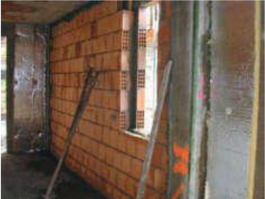
Fig. 7.6: Messa in opera di una parete a "cassavuota".
