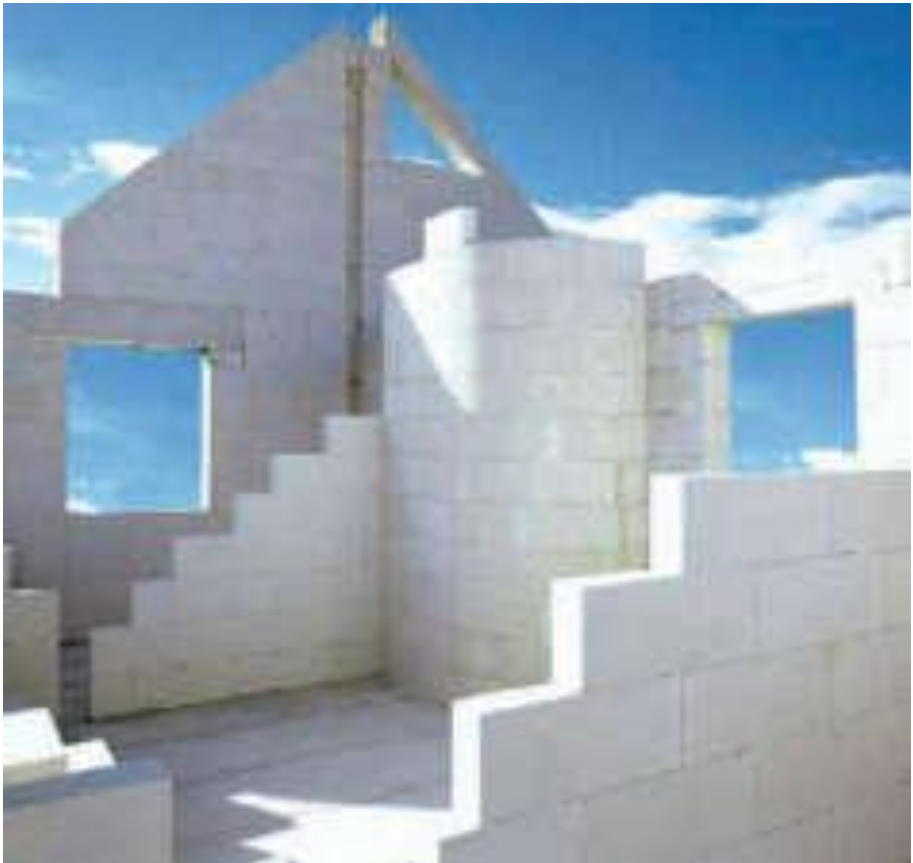
Fig. 7.17: Edificio realizzato esclusivamente con blocchi Ytong di varia tipologia.
