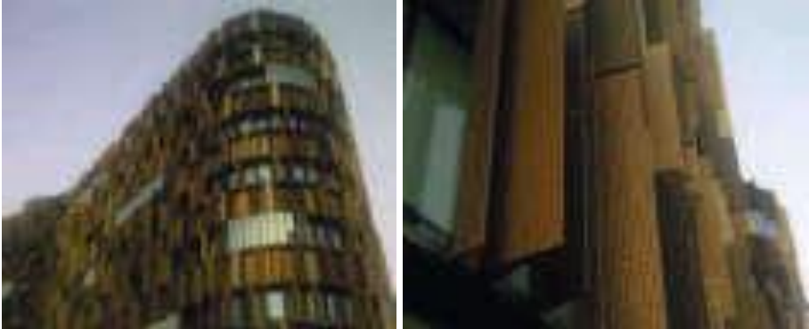
Fig. 7.73: Frangisoli esterni fissi. Edificio U15 dello studio CZA Cino Zucchi Architetti a Milanofiori (MI).
