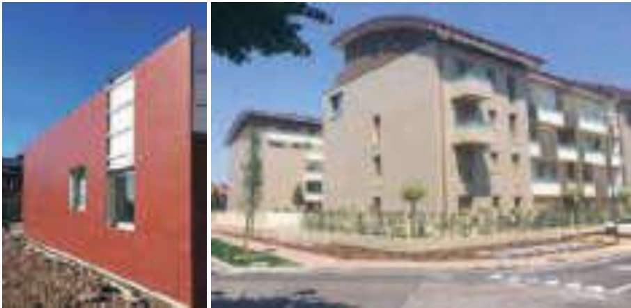
Fig. 7.55: Edifici realizzati con il sistema Isotec. A sinistra “Impresa Paccagnella” a Pieve di Cadore (BL); a destra “Corti Milanesi” a Mirano (VE).
