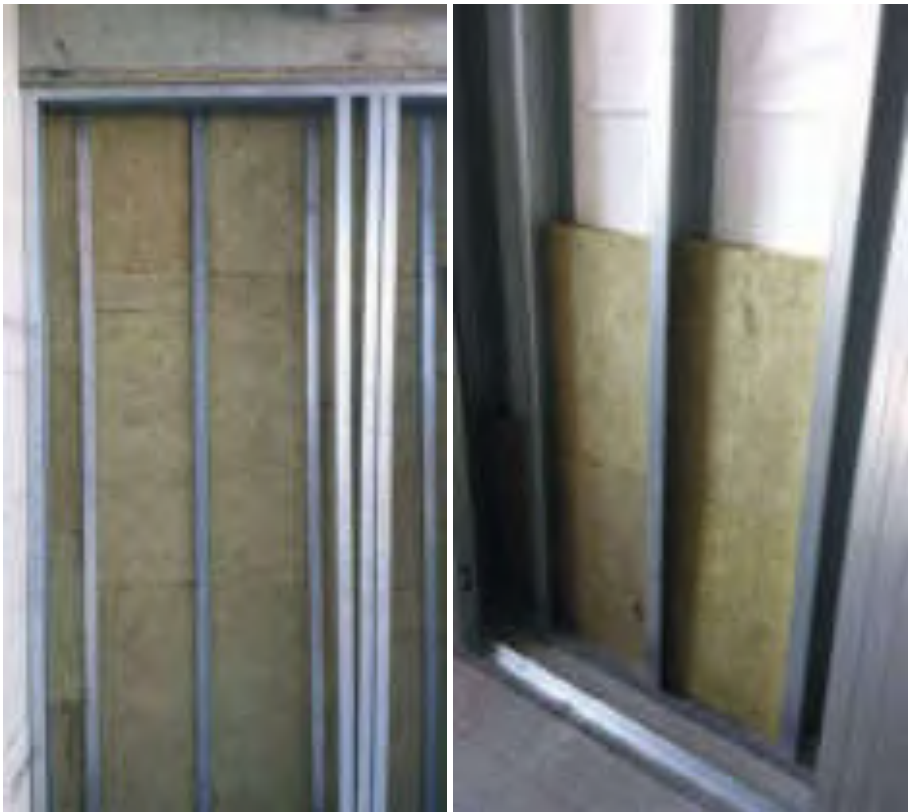
Fig. 7.12: Condominio Posta 1, Corpo A - Mirandola (MO). Fonte: Knauf S.r.l.
