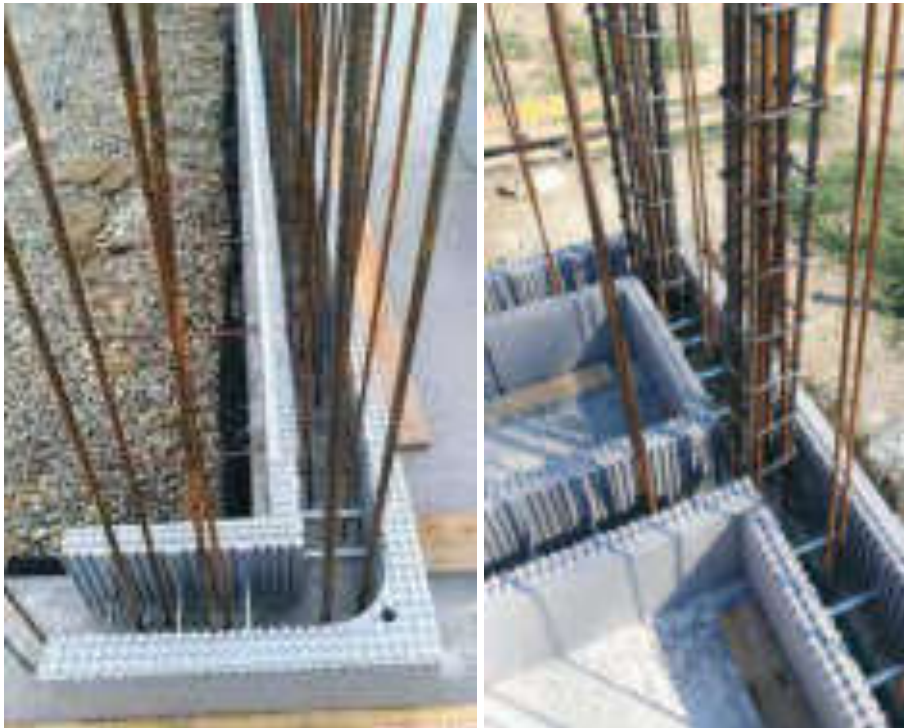
Fig. 7.33: Messa in opera del primo corso di blocchi cassero coibentati di polistirene espanso e posizionamento dei ferri di armatura. Sistema costruttivo Bioisotherm - Argisol. Fonte: Bioisotherm S.r.l.
