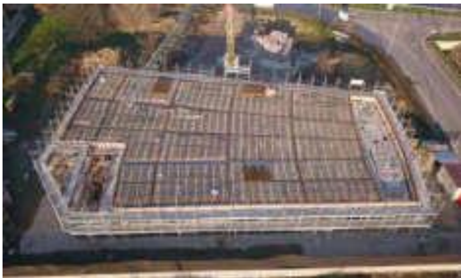
Fig. 7.25: Realizzazione di 8 alloggi a Cremona (CR) con blocchi e solai Isotex.
