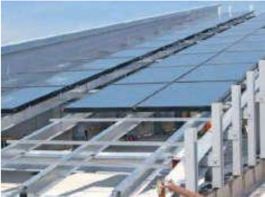
Fig. 7.67: Montaggio dei pannelli al telaio della facciata continua. Complesso multifunzionale Verona Forum progettato dall'architetto Mario Bellini a Verona. Fonte: Guastoni, C. (2011) 191 .
