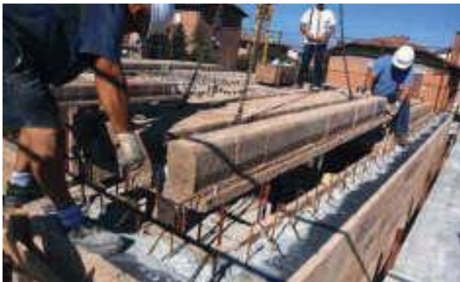
Fig. 7.29: Posa dei pannelli-solaio Isotex calcolati e realizzati su misura. Fonte: Isotex S.r.l.
