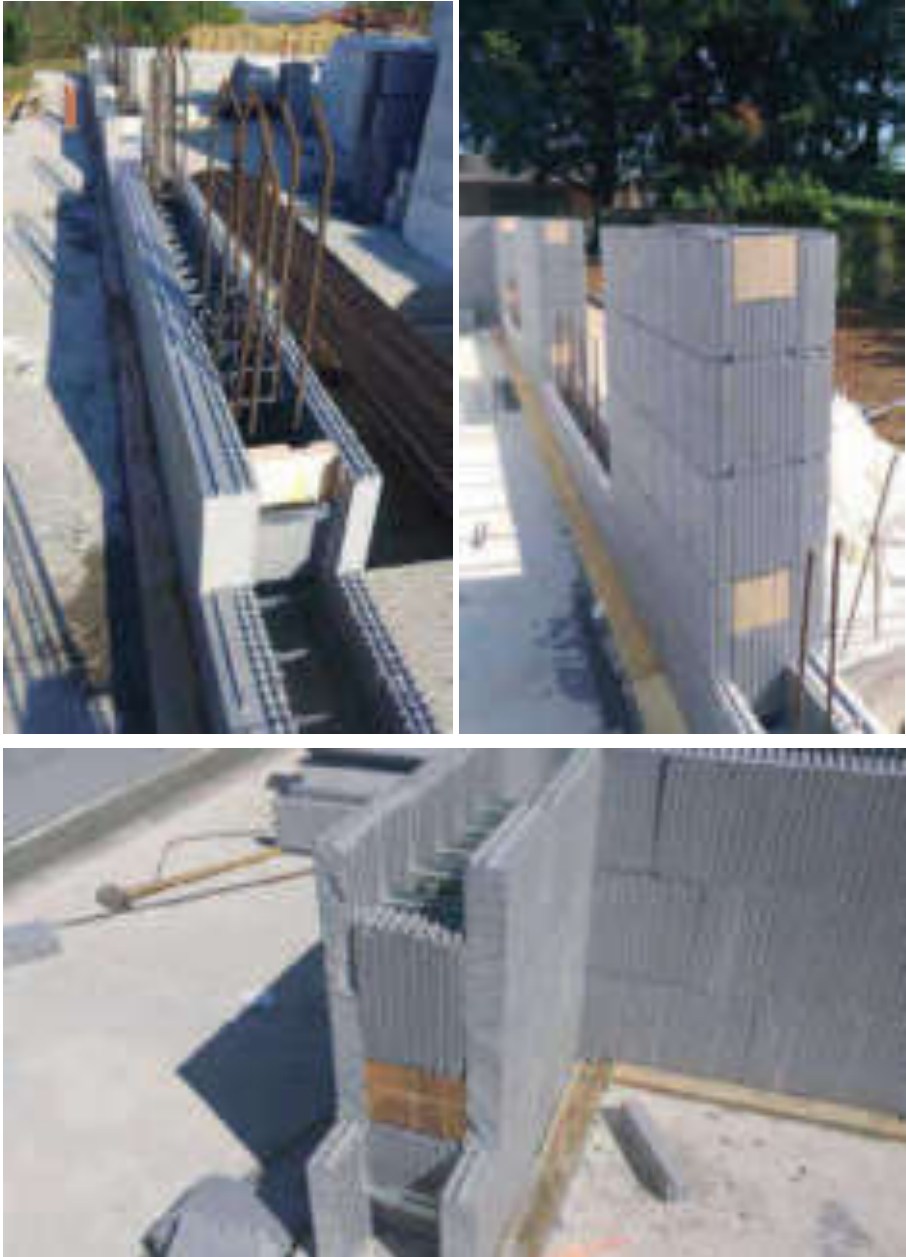
Fig. 7.34: Messa in opera tramite incastro dei blocchi cassero coibentati di polistirene espanso per la realizzazione di una parete. Sistema costruttivo Bioisotherm - Argisol.
