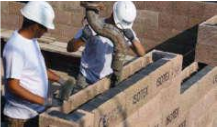
Fig. 7.27: Colata di calcestruzzo all'interno dei blocchi Isotex (effettuata ogni 6 corsi). Fonte: Isotex S.r.l.
