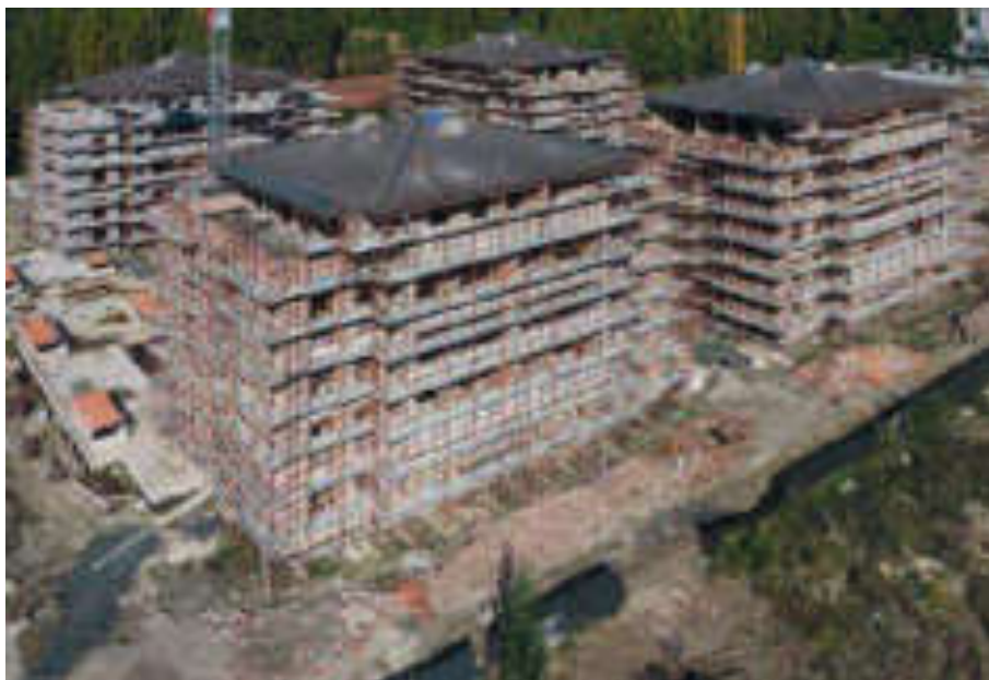
Fig. 7.24: Realizzazione di 70 alloggi a Parma con i blocchi Isotex.
