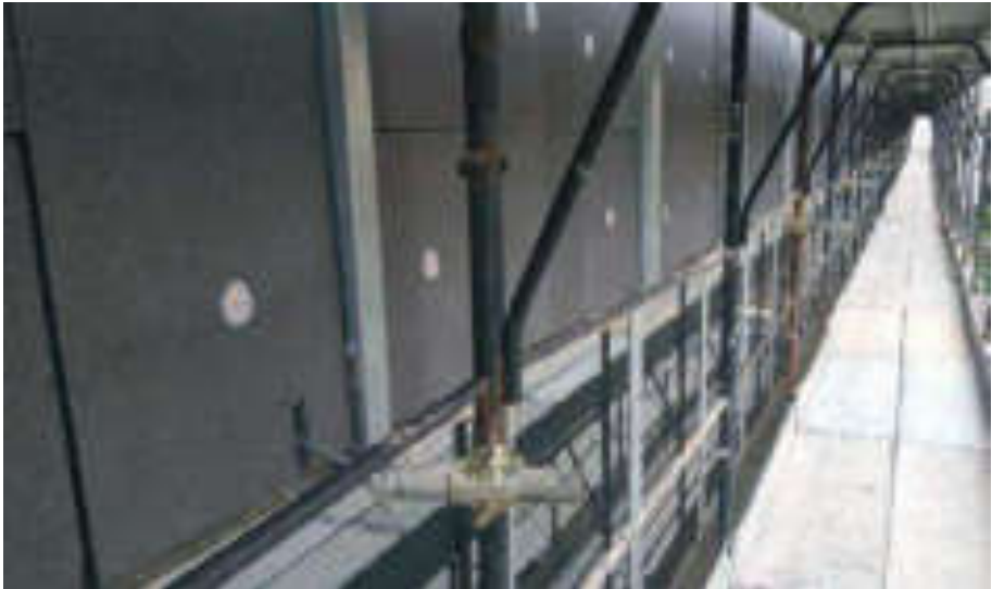
Fig. 7.45: Esecuzione di una facciata ventilata su un edificio esistente: l'isolamento, in lastre di polistirene espanso (EPS), è posizionato tra gli elementi verticali della sottostruttura metallica portante, agganciata a sua volta allo strato resistente.
