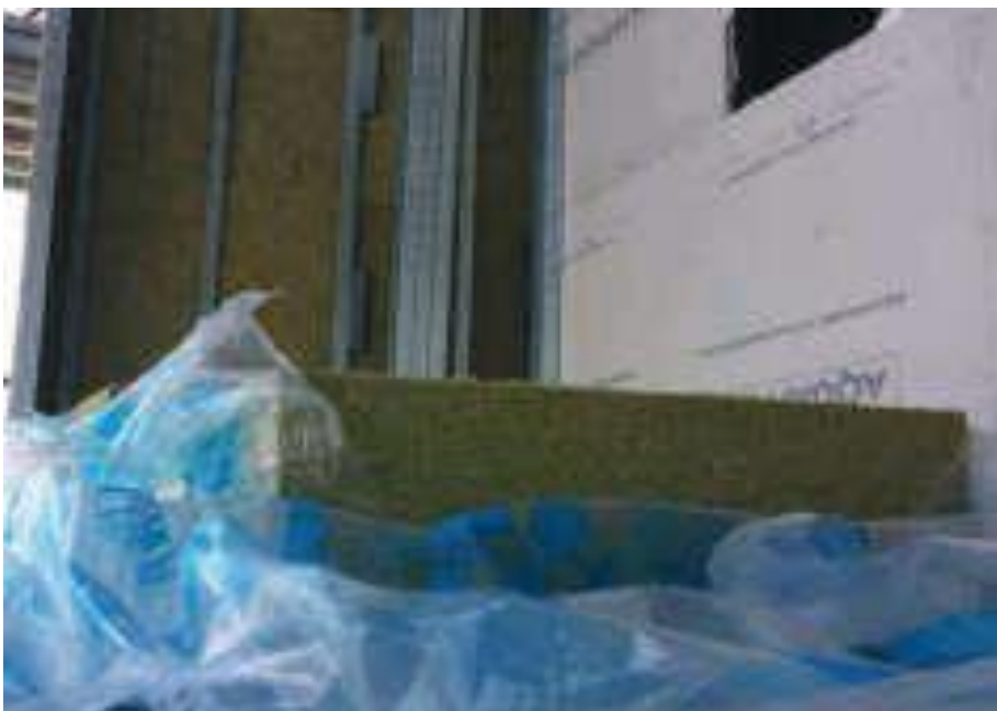
Fig. 7.11: In alto: sistema di montanti e guide con interposto il materiale isolante e installazione dei montanti delle finestre. In basso: particolare del materassino di lana isolante da collocare fra i montanti. Condominio Posta 1, Corpo A - Mirandola (MO).
