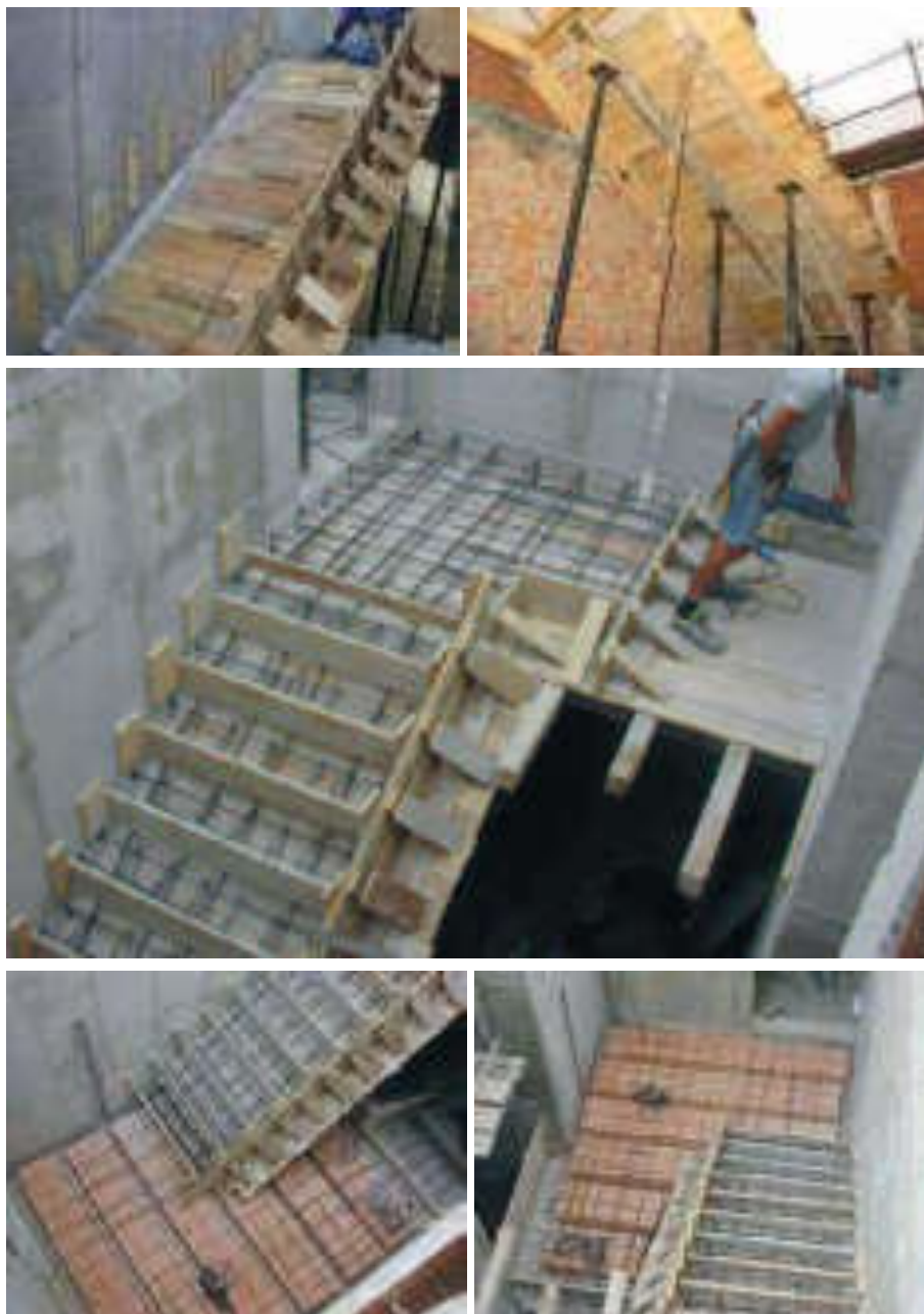
Fig. 10.11: Le fasi per la realizzazione di una scala di calcestruzzo armato gettato in opera.
