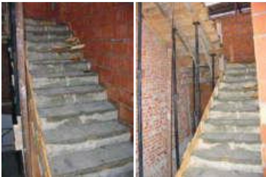
Fig. 10.12: La gettata di calcestruzzo per il completamento della scala.
