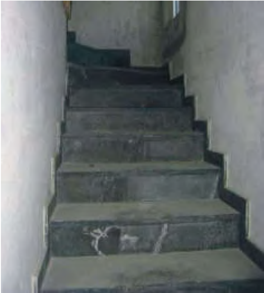
Fig. 10.7: Scala interna rivestita con pietra naturale.
