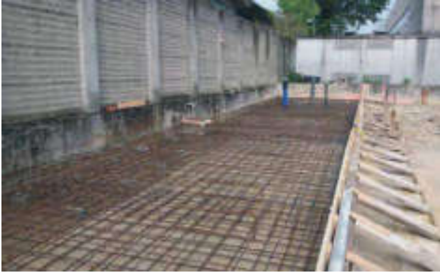
Fig. 5.8: Realizzazione di una fondazione a platea.
