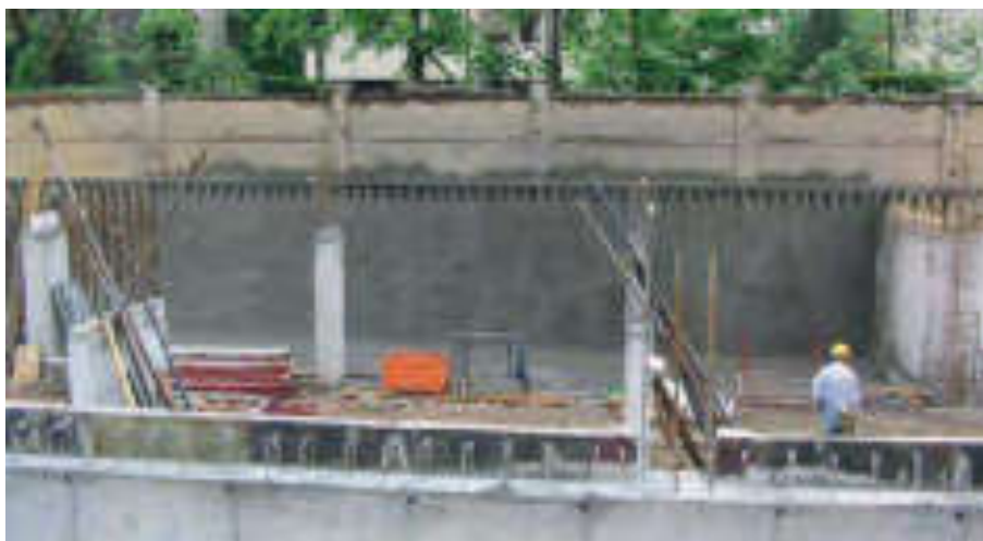
Fig. 5.22: Applicazione dello SpritzBetón sui micropali. La tecnica dello SpritzBetón (o calcestruzzo spruzzato) consiste nello spruzzo, mediante una lancia ad aria compressa, di una miscela cementizia additivata con prodotti acceleranti di presa. Questi ultimi consentono l'aggrappo istantaneo del conglomerato nel momento in cui raggiunge la superficie di applicazione garantendo una massa compatta e omogenea.
