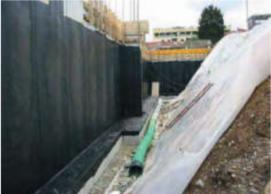
Fig. 5.35: Particolari della posa delle impermeabilizzazioni (guaina bentonitica impermeabilizzante color nero) sui muri contro terra e dei drenaggi.
