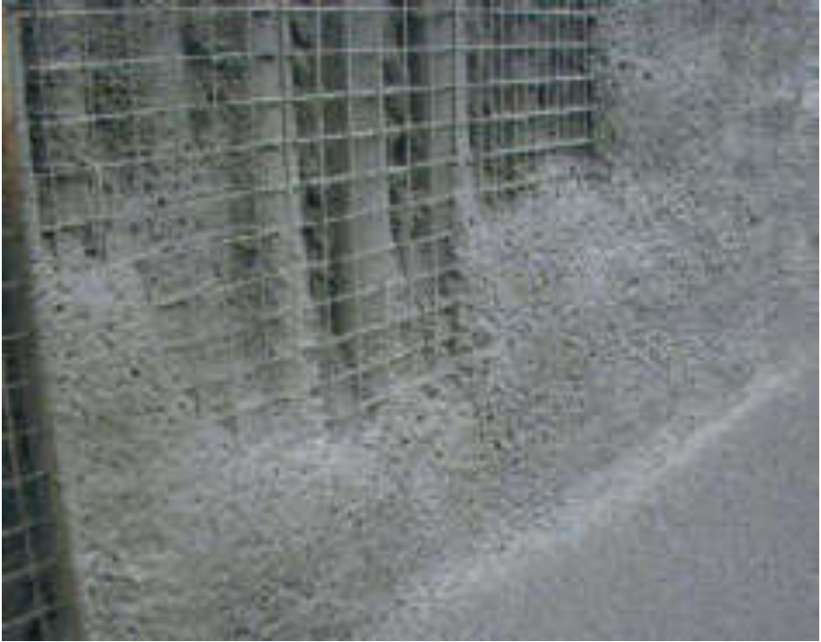
Fig. 5.23: Dettaglio dell'applicazione dello SpritzBeton sui micropali.
