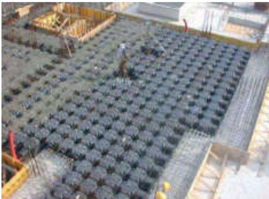
Fig. 5.34: Gettata di calcestruzzo per il completamento del vespaio, sormontato dalla rete elettrosaldata.
