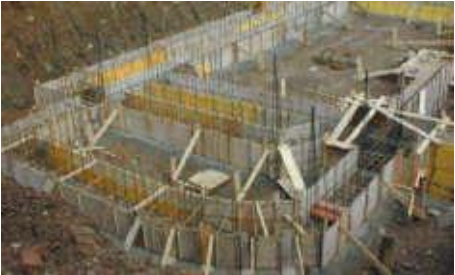
Fig. 5.5: Casserature per la realizzazione delle travi rovesce.
