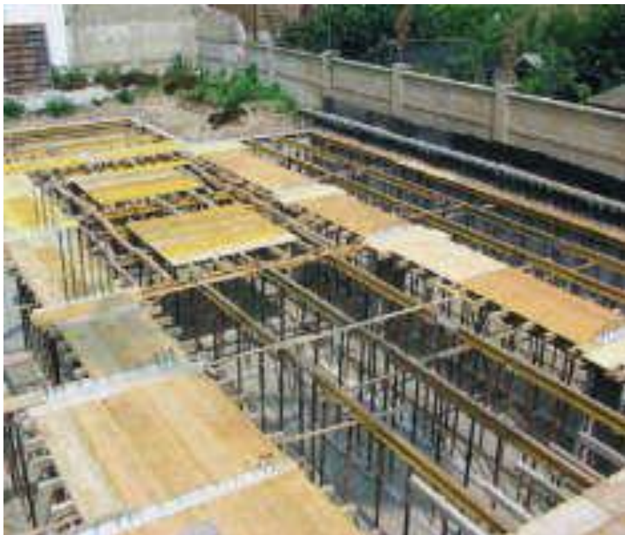
Fig. 5.26: Vista generale del cantiere con a lato i micropali.
