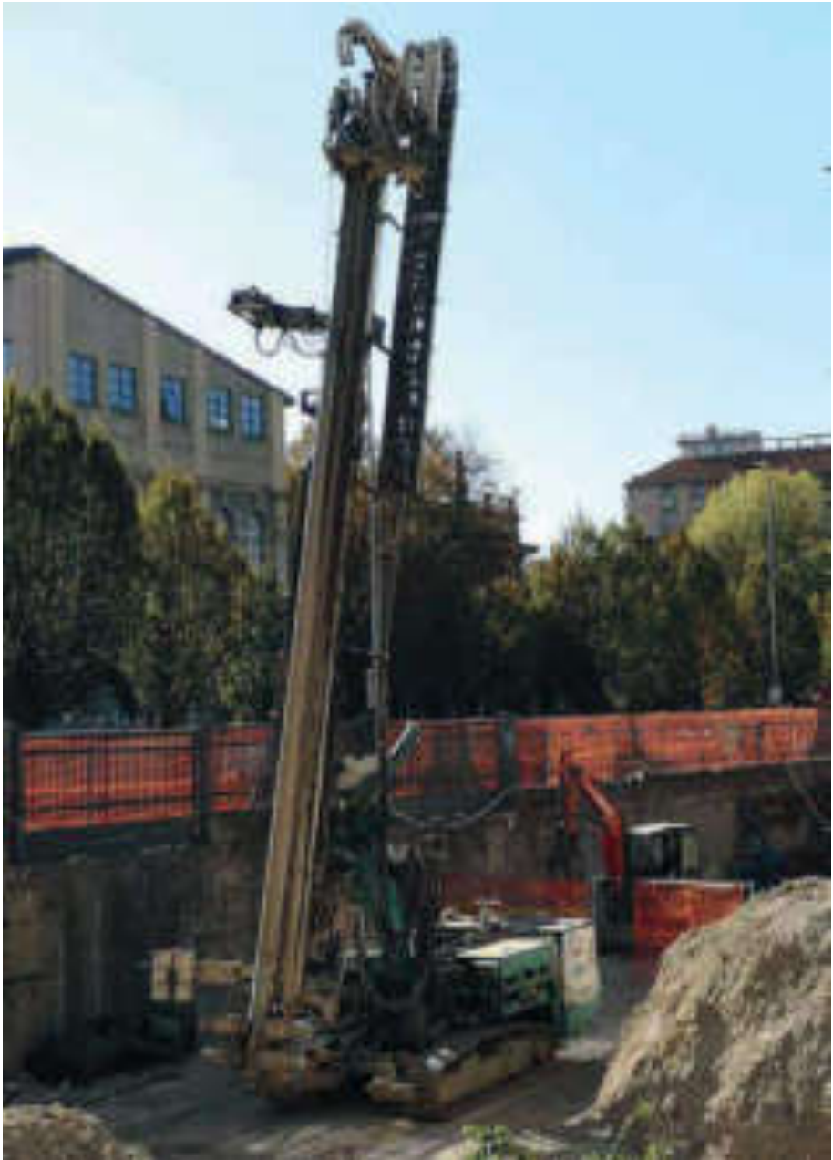
Fig. 5.17: Macchina battipalo o "berta". Cantiere: Campus di Architettura di via Bonardi, Politecnico di Milano.
