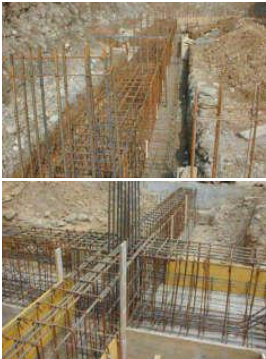
Fig. 5.6: Fasi per la realizzazione di una fondazione a trave rovescia. Fase 1 (in alto): esecuzione dello scavo di sbancamento, realizzazione del magrone e posizionamento dei ferri di armatura. Fase 2 (in basso): posizionamento dei ferri di ripresa per la realizzazione dei pilastri.
