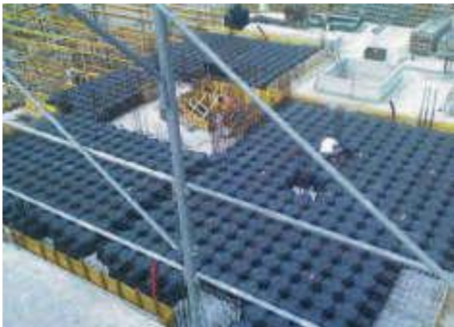
Fig. 5.32: Solaio contro terra realizzato con casseri a perdere di plastica riciclata (igloo).
