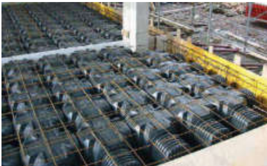
Fig. 5.33: Dettaglio del posizionamento degli igloo.
