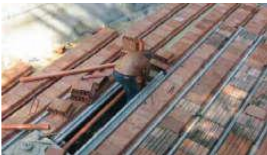
Fig. 5.31: Vespaio a secco: messa in opera (sopra i muretti precedentemente realizzati) dei tavelloni di cotto e dei travetti precompressi.
