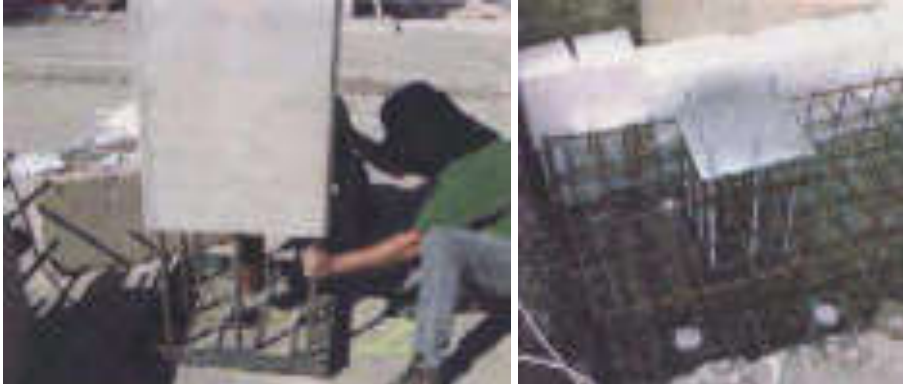
Fig. 5.13: A sinistra alloggiamento del pilastro prefabbricato su trespole di fondazione annesso nella platea; centraggio del pilastro attraverso il tubolare di piombatura e posizionamento dei ferri di collegamento; a destra dettaglio delle armature di fondazione e della piastra con tirafondi.
