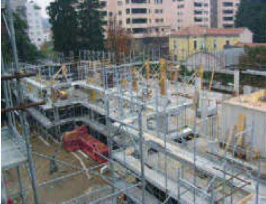
Fig. 6.1: Cantiere di un edificio con struttura in elevazione verticale a telaio.
