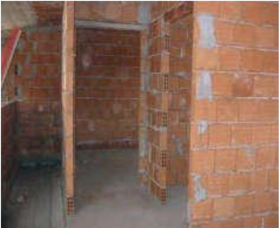
Fig. 6.21: Pareti divisorie interne realizzate con mattoni forati.
