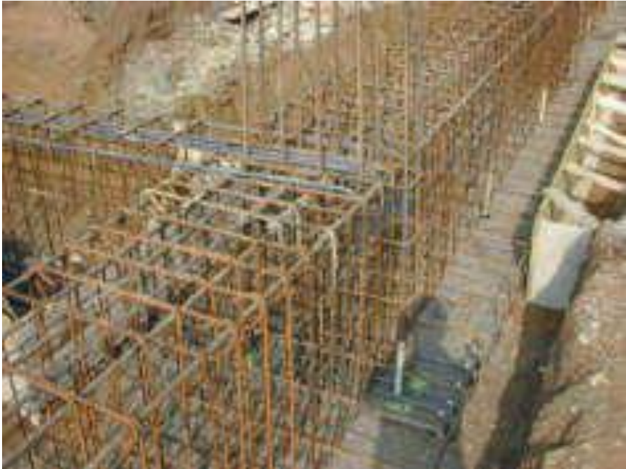
Fig. 6.3: Barre di acciaio e staffe di travi e pilastri.
