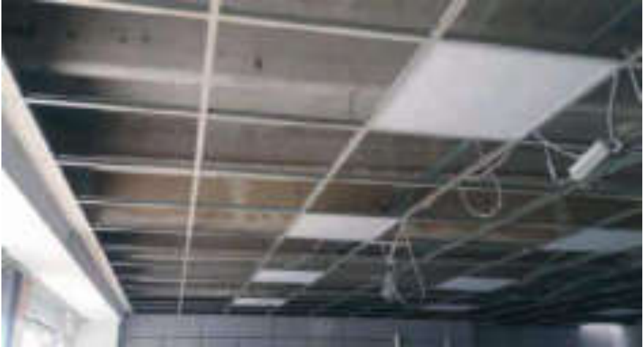
Fig. 8.25: Messa in opera di un controsoffitto.
