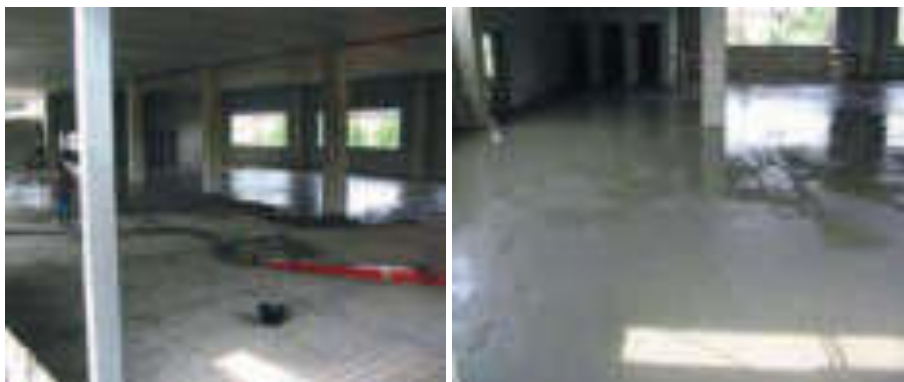
Fig. 8.18: Fasi per la realizzazione di un pavimento di calcestruzzo gettato in opera: posa della rete elettrosaldata e gettata di calcestruzzo opportunamente rullata.
