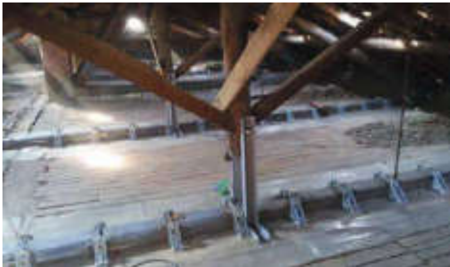
Fig. 8.17: Consolidamento di un solaio di legno con carpenterie metalliche e fibre di carbonio: posa della pavimentazione di legno.
