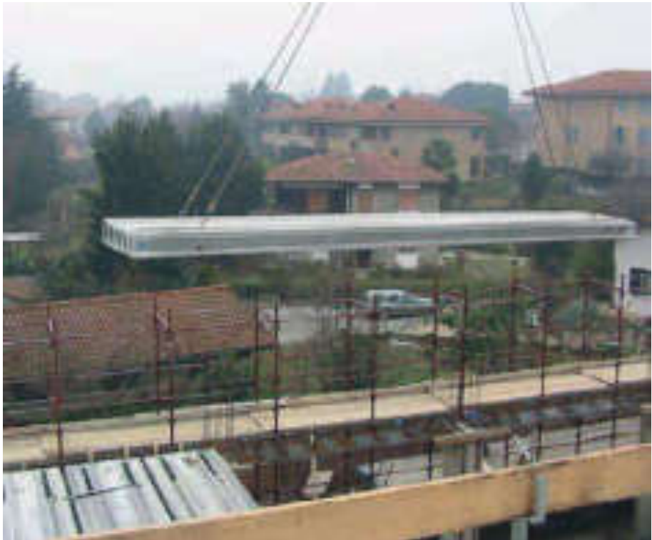
Fig. 8.12: Assemblaggio in cantiere di un pannello prefabbricato di tipo alveolare.
