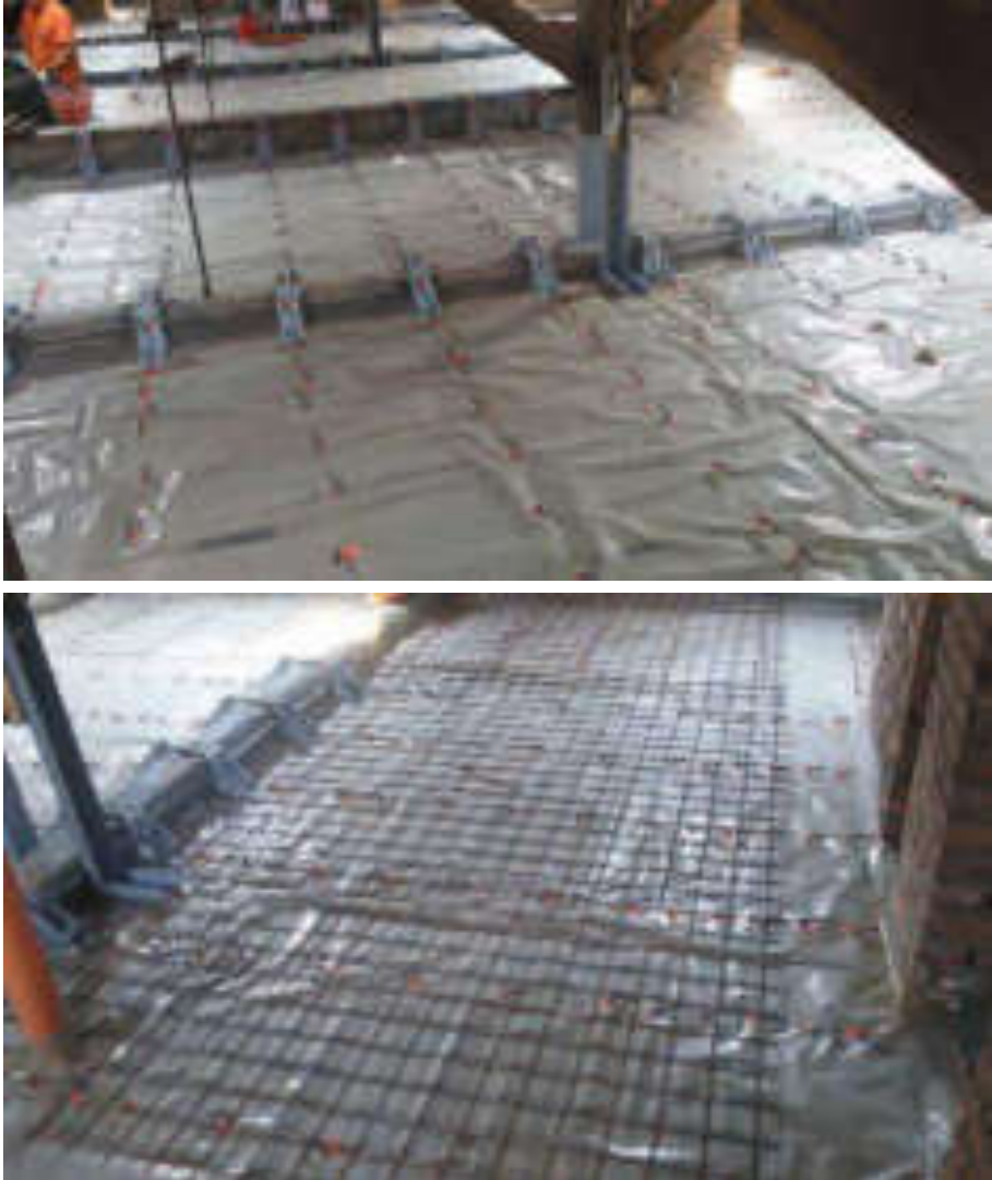
Fig. 8.16: Consolidamento di un solaio di legno con carpenterie metalliche e fibre di carbonio: posa in opera della rete elettrosaldata e dei connettori metallici. Seguirà la gettata di calcestruzzo alleggerito.
