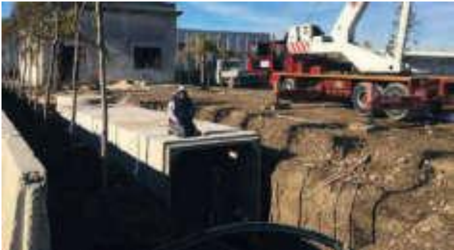
Fig. 11.23: Realizzazione di un impianto di prima pioggia.
