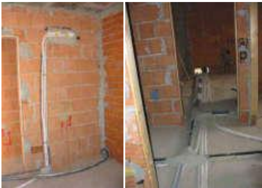
Fig. 11.8: Posizionamento in traccia degli impianti di condizionamento a Split.
