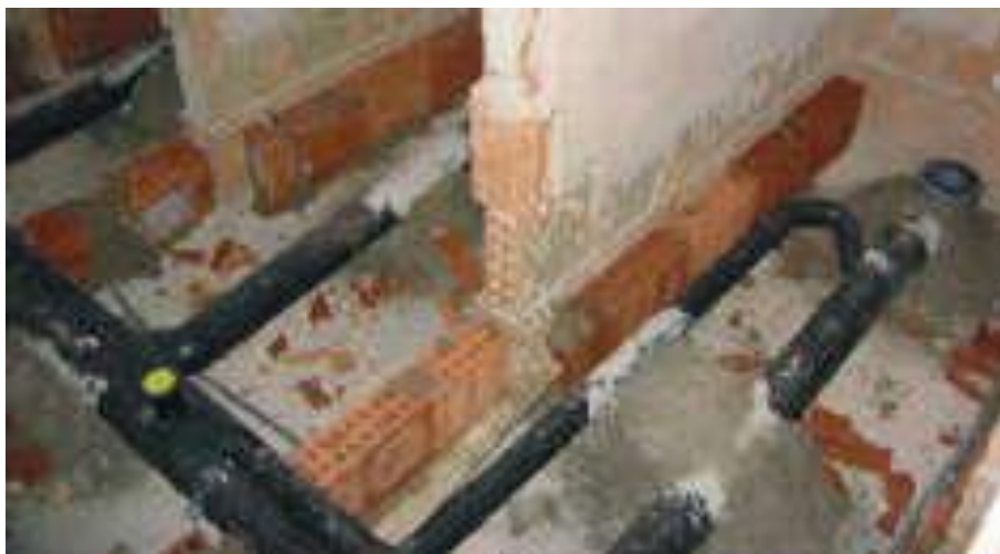
Fig. 11.18: Impianto idrico di scarico delle acque nere: le diramazioni di scarico collegano i sifoni dei singoli apparecchi sanitari alla colonna di scarico.
