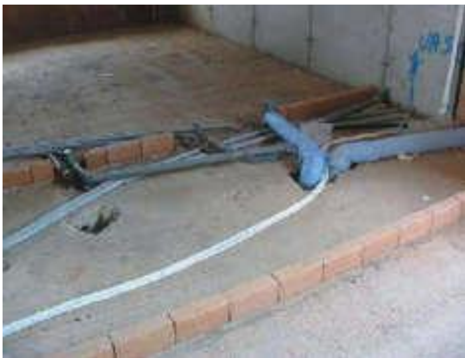
Fig. 11.19: Impianto idrico di scarico: le diramazioni di scarico convogliano le acque nella colonna di scarico.
