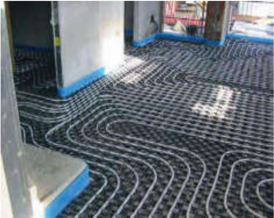
Fig. 11.5: Posizionamento delle serpentine per il riscaldamento a pavimento.
