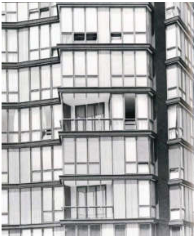
Fig. 3.14: Edificio in via Quadronno: particolare della facciata dell'edificio. Fonte: Studio Mangiarotti.
