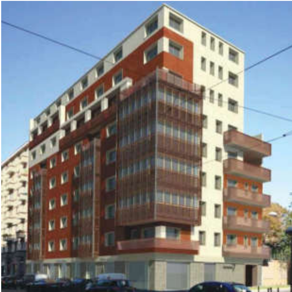
Fig. 8.64: "L'Edificio di Viale Corsica, Milano". Vista generale. Fonte: Garretti Associati, Arch. Paolo Garretti.
