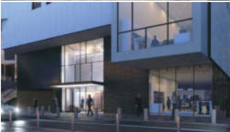
Fig. 8.37: Vista dell'ingresso dell'edificio. Fonte: Caputo Partnership, Arch. Paolo Caputo.
