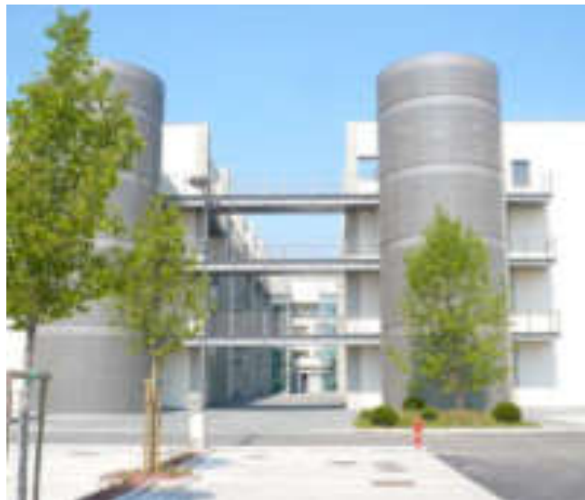
Fig. 8.106-8.107: I collegamenti verticali: le passerelle e il blocco ascensori. Fonte: Studio Marco Piva, Arch. Marco Piva.
