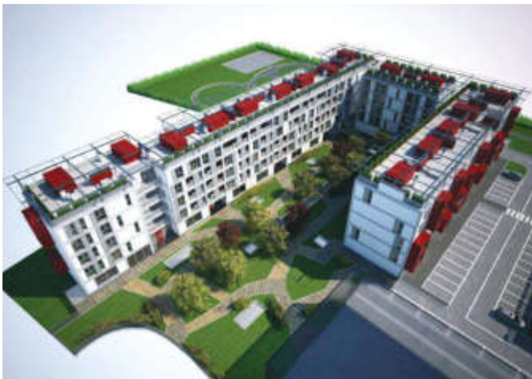
Fig. 8.87: Vista aerea del complesso residenziale. Fonte: Progetto CMR, Arch. Massimo Roj.
