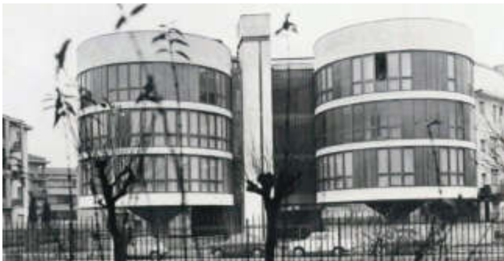
Fig. 3.6: L'edificio per abitazioni in via Gavirate a Milano. Fonte: Studio Mangiarotti.
