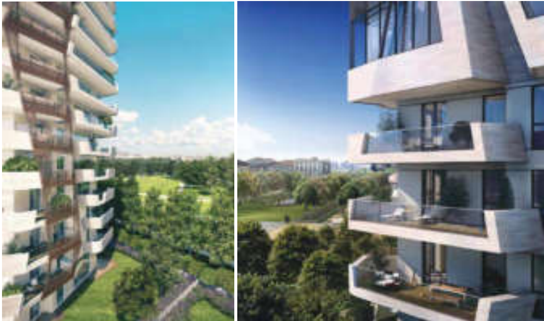
Fig. 8.49-8.50: Le Residenze Libeskind: alcuni scorci del complesso residenziale inserito nel verde cittadino. Fonte: Sigest S.p.A. e CityEdge, Archh. Luca Mangione ed Attilio Terragni.
