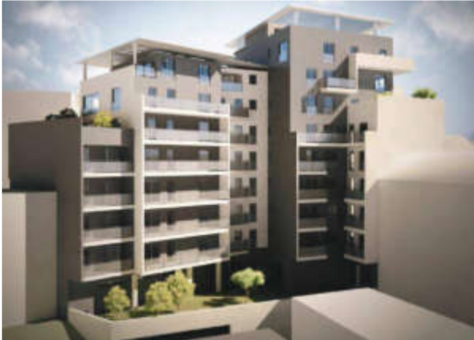
Fig. 8.12: "L'Edificio di via Muratori, 13, Milano": vista interna. Fonte: Archimi Studio, Arch. Marco Cerri.
