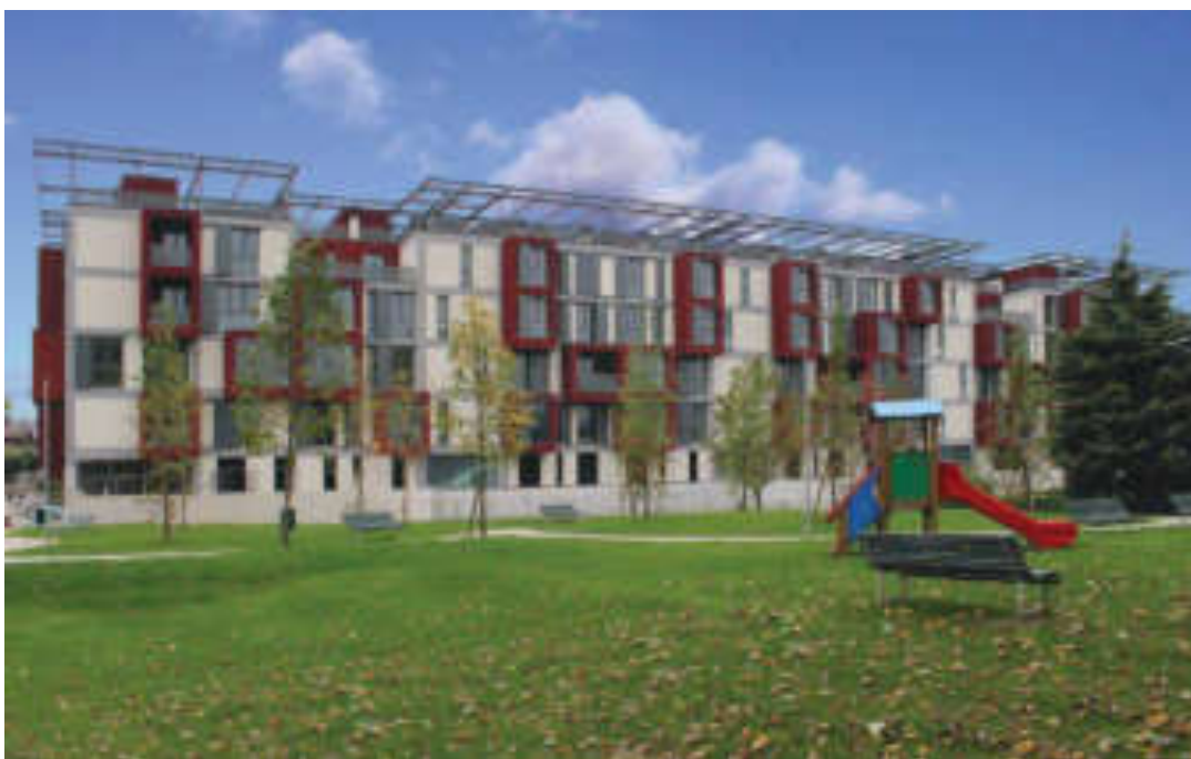
Fig. 8.88: Vista esterna dell'edificio dove sono si possono scorgere le logge e i bow windows. Fonte: Progetto CMR, Arch. Massimo Roj.
