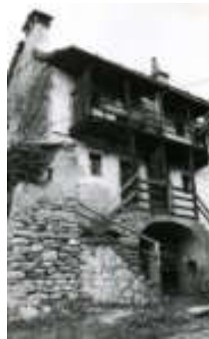
Fig. 5.4: Casa d'abitazione con ballatoio sul lato di gronda Toriggia, Val Divedro. Fonte: Fotografie di G. Pessina.
