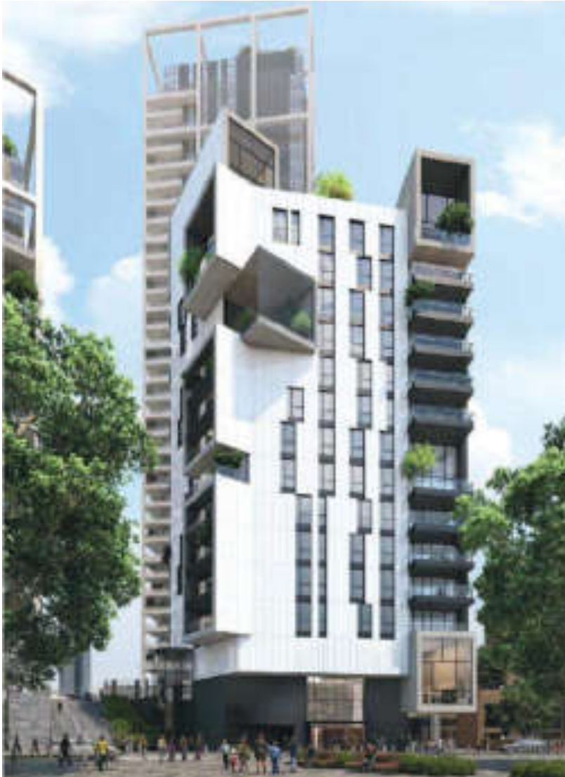
Fig. 8.36: "L'Edificio Solea": vista esterna. Fonte: Caputo Partnership, Arch. Paolo Caputo.
