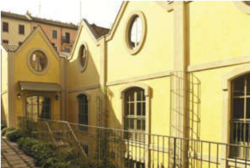
Fig. 8.26-8.27-8.28: Alcune panoramiche degli ex capannoni trasformati in residenze. Fonte: Associati, Archh. Daniele Fiori e Francesco Lorenzelli.
