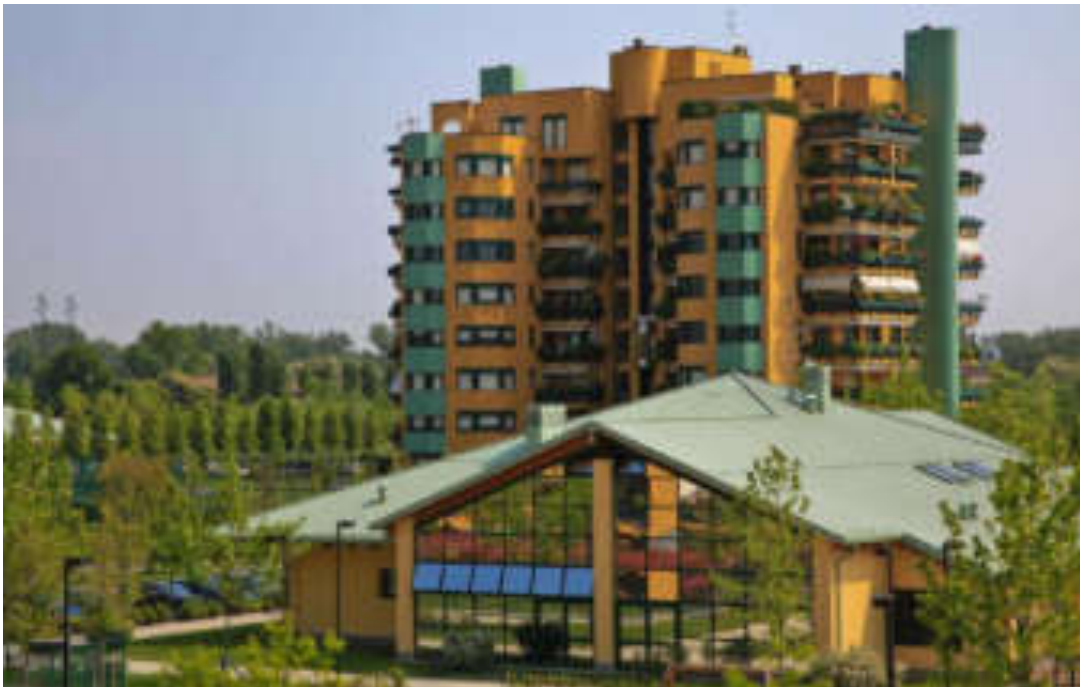
Fig. 5.21: "Il Quartiere Malaspina a Pioltello", la Club House. Fonte: Prelios, Fotografie di S. Hermann.
