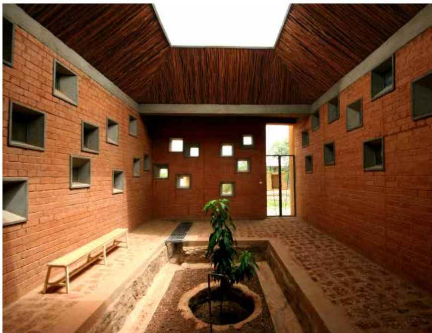
12 Detail of an entrance @ Kéré Architecture, ph. Erik-Jan Ouwerkerk.
