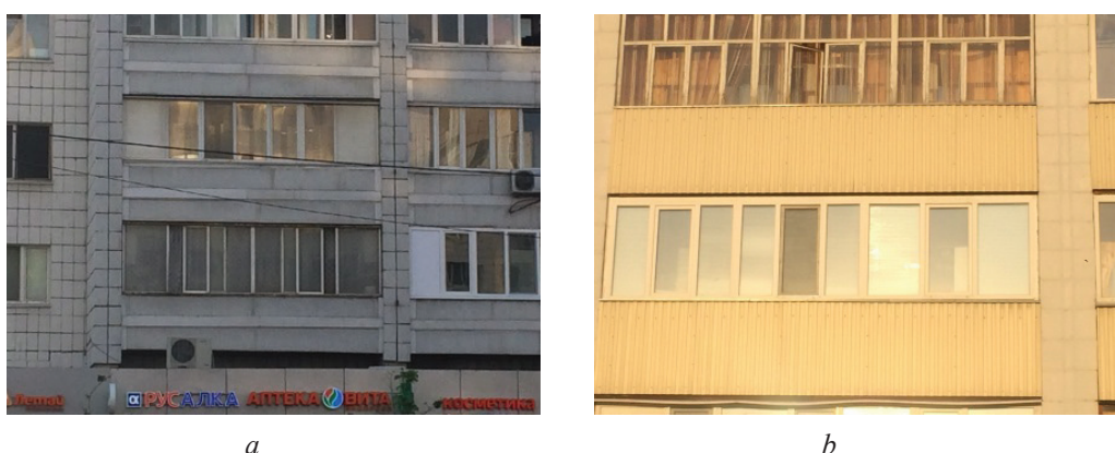
Рис. 14. Фрагменты фасадов зданий после ремонта декоративных элементов — плит ограждения лоджий. Жилой дом по адресу: Казань, ул. Вишневого, д. 14, 53: a — металлическими пластинами закрыто отверстие между плитами, проведена покраска типовой гладкой поверхности плиты ограждения лоджии; b — установлены цветные металлические ограждения поверх исторического декора (источник: исследование авторов)
