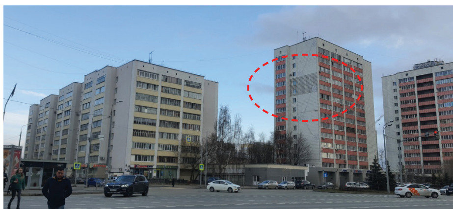
Рис. 7. Точечное решение по ремонту — утепление фасада только одной квартиры (герметизация стыков) жилого дома по адресу: Казань, ул. Вишневского, д. 55 (источник: исследование авторов)
