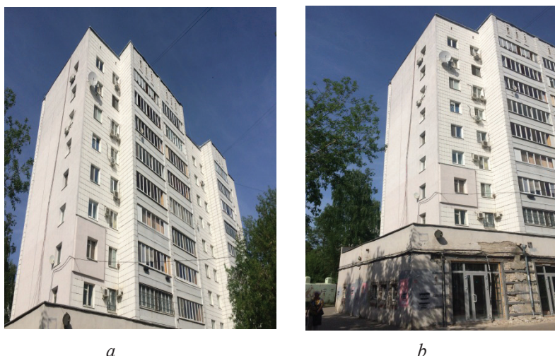
Рис. 12. Торцевое решение при ремонте фасада и одной угловой квартиры — утепление только западного фасада и одной угловой квартиры. Жилой дом по адресу: Казань, ул. Вишневого, д. 14: a — утепление западного фасада; b — утепление только одной угловой квартиры на третьем этаже (источник: исследование авторов)
