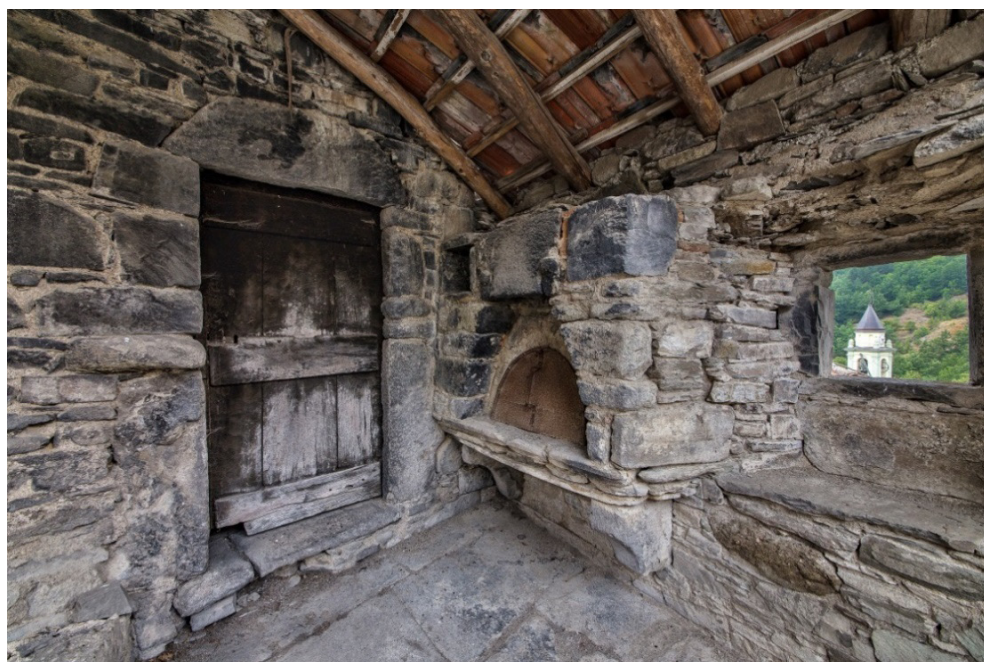
Fig. 9 – Gramizzola (PC). La copertura in ciappe è stata sostituita con tegole marsigliesi, ma l'edificio conserva le caratteristiche dell'architettura eulitica. Fotografia di G.A. Turco.
