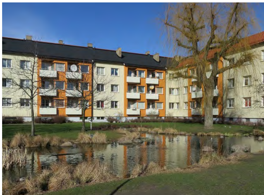
Fig. 2 - Pompe di circolazione, piccole cascate d'acqua e fontane evitano la formazione di alghe / Circulation pumps, small water falls and fountains avoid algae growth (Photograph by Jorchr, CC BY-SA 3.0 < https://creativecommons.org/licenses/by-sa/3.0/ >, via Wikimedia Commons).
