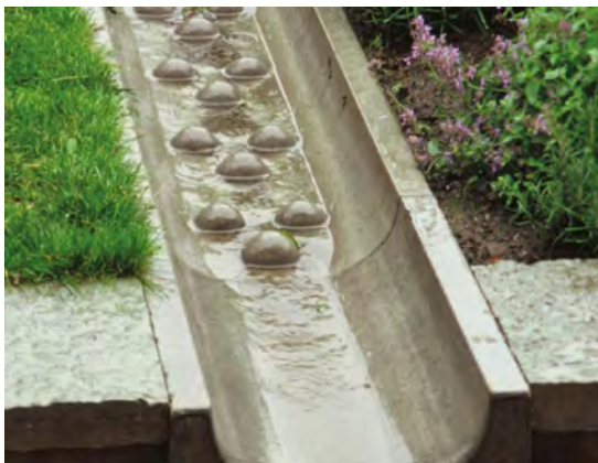
Fig. 6 - Canali di scolo progettati per provvedere all'autopurificazione dell'acqua / Gutters designed to provide for some self-purification of water (Source: https://www.vasyd.se/-/media/Documents/Informationsmaterial/Vatten-och-avlopp/Dagvatten/Augustenborg_2008_en_webb.pdf ).
