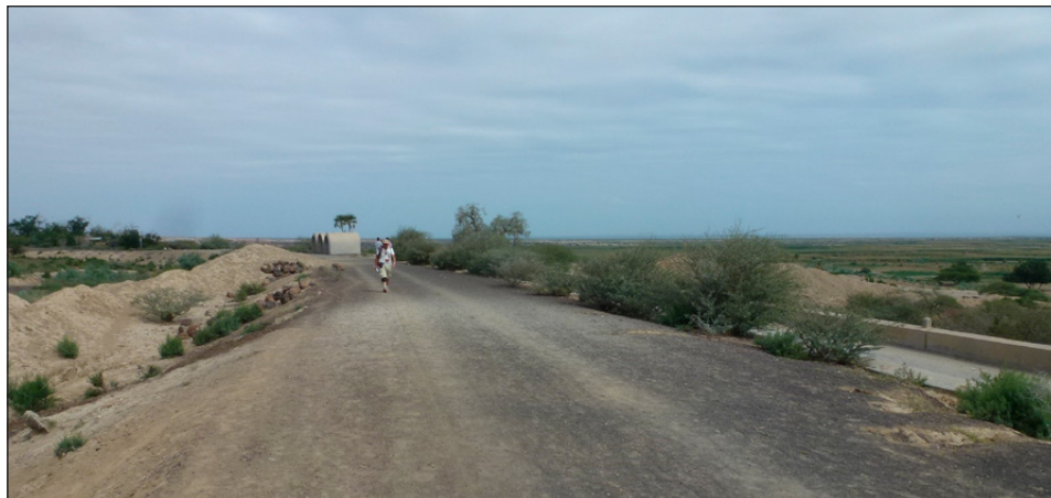
Fig. 3 – La strada che percorre la sommità della diga di Foro: a sinistra è possibile osservare volumi di terra a ridosso della carreggiata e constatare l'assenza di acqua (foto 2015).
