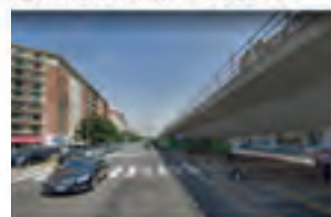
2 SOTTOPASSAGGIO STAZIONE ROGOREDO
