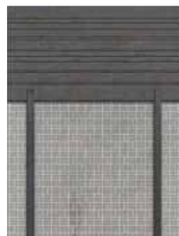
13/14 - Le nuove facciate del forno Hofmann realizzate con manufatti in laterizio ricavati dal catalogo di produzione della fornace. Il tamponamento di facciata lascia filtrare aria e luce
