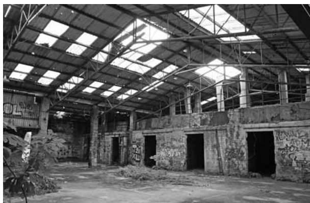
C/D - Interno fornace Fusi
