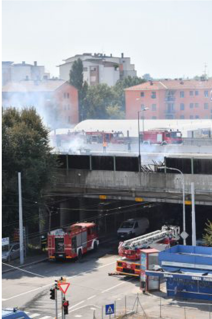
Figure 13 Les câbles d'alimentation de la ligne de trolleybus, dont les câbles ont une tension de 600 V, auraient été affectés par l'incendie qui a ensuite provoqué l'explosion.
