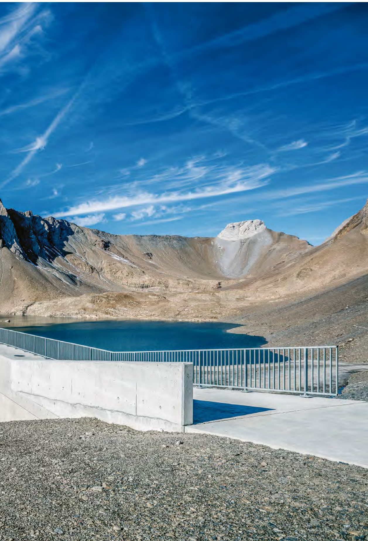
Lombardi SA Ingegneri Consulenti, diga del Muttsee, vista da ovest. Foto Axpo
