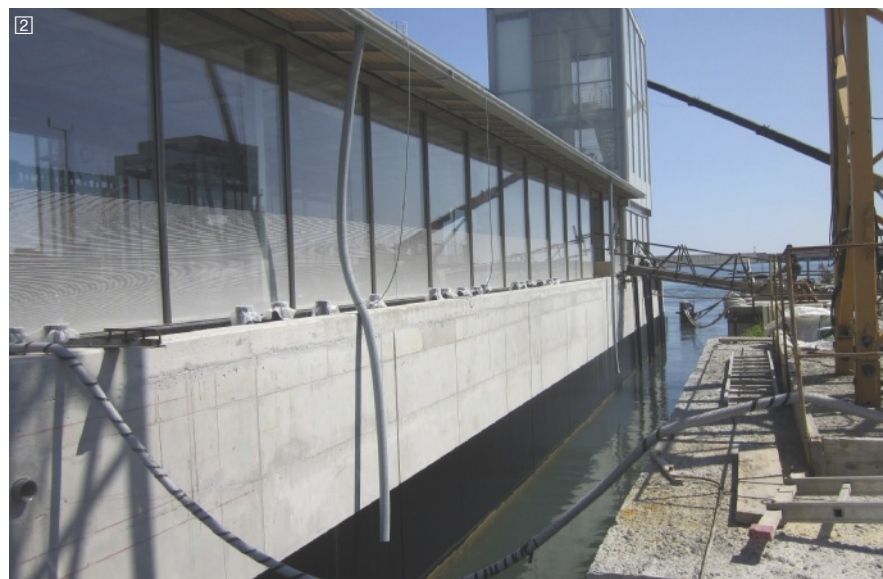
Immagine 2. Sequenza costruttiva: fase di montaggio dei componenti di involucro secondo l'esecuzione delle intelaiature alle sezioni portanti orizzontali in c. a. e all'orditura sia verticale sia di copertura in acciaio
