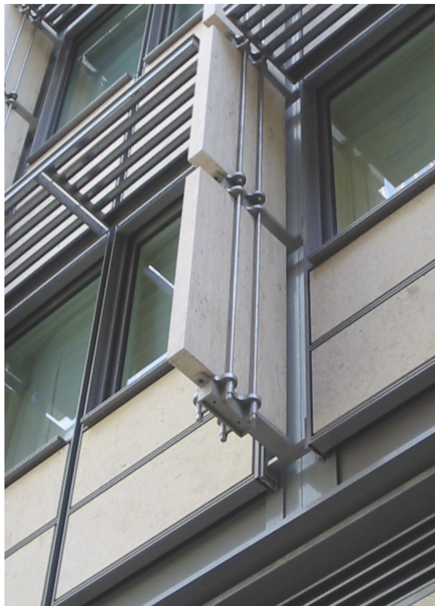
Immagine 2. Elaborazione delle chiusure in pietra secondo la trasmissione dei carichi attraverso le interfacce realizzate dalla sottostruttura, dal montaggio indipendente delle lastre, dai sostegni profilati e dai perni di ancoraggio
