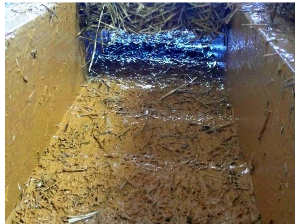
Modulo dimostrativo Isolamento di soletta in balle di paglia e terra - Cantiere-scuola a Strée
