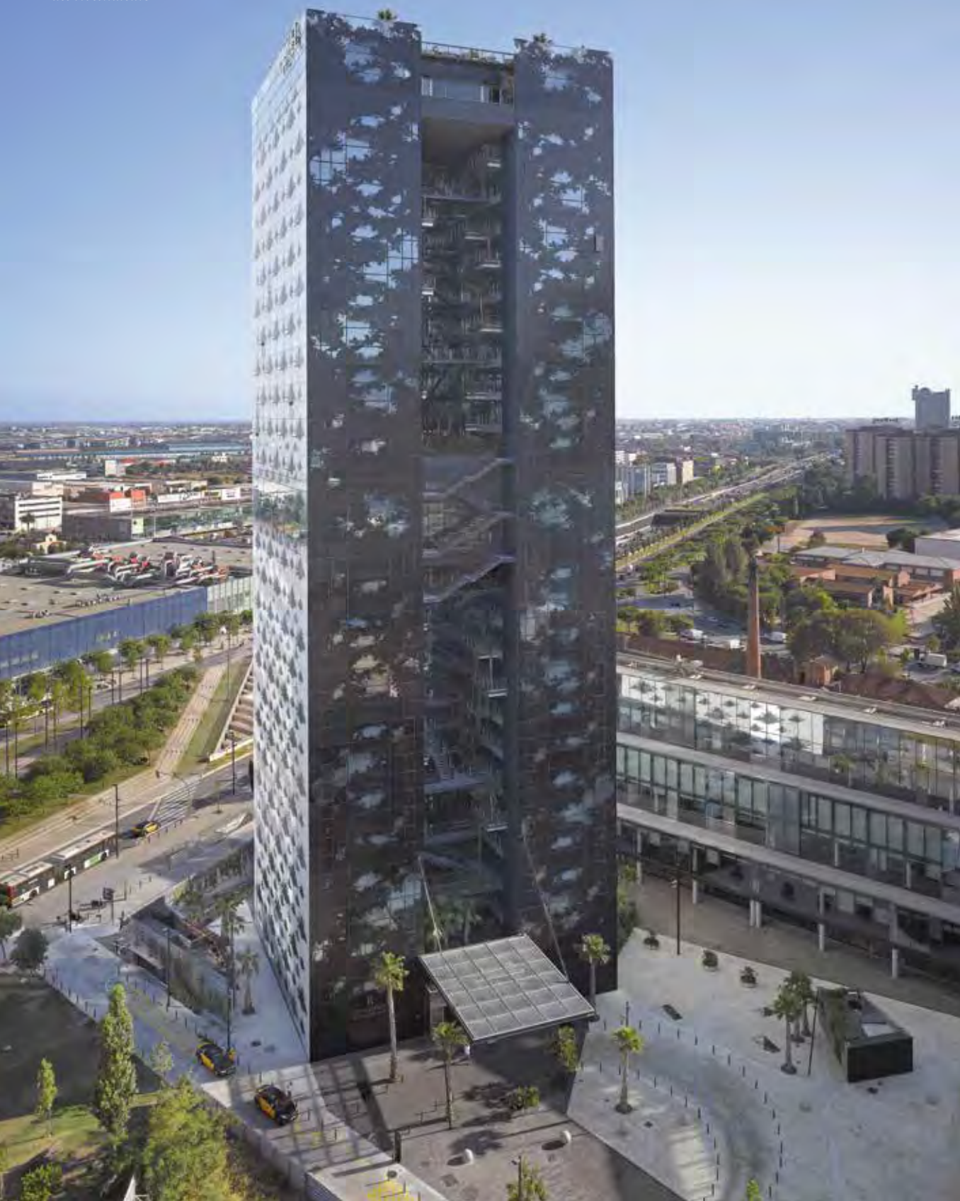
Vista esterna e dettaglio del rivestimento
