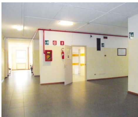
Ampi spazi di connettivo possono essere un'importante risorsa per alleggerire le classi e per allestire nuovi ambienti.
