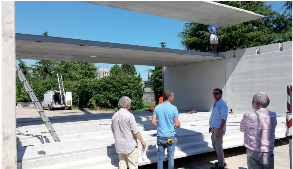
Solaio in fase di assemblaggio sui muri
