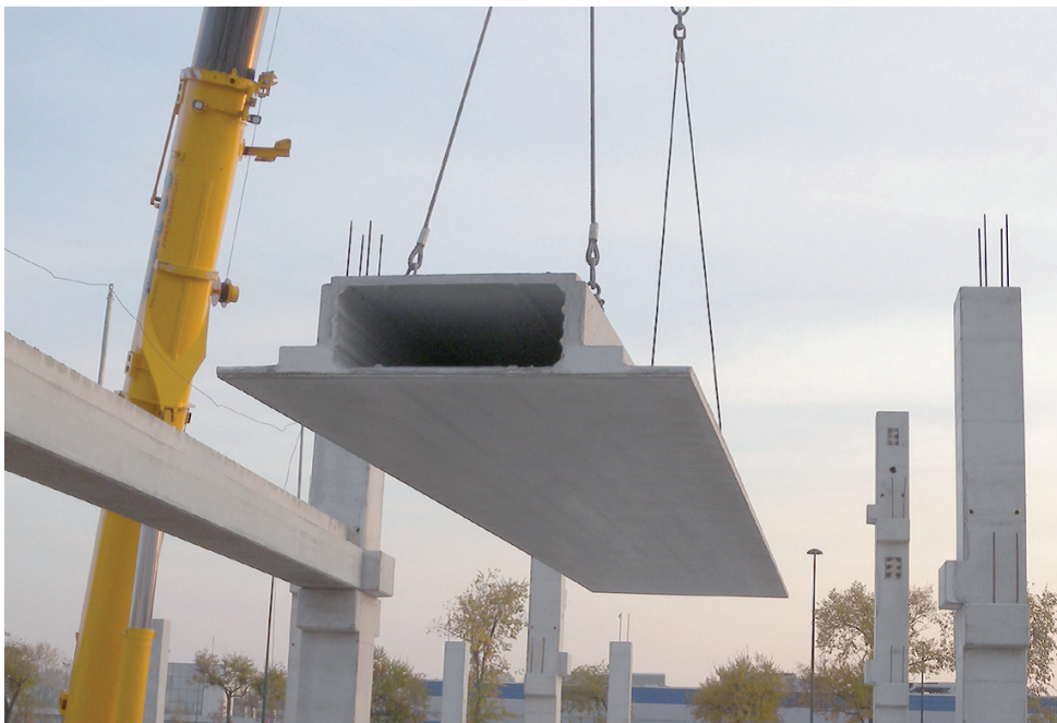
Edificio Pandal® in fase di assemblaggio (cortesia A. Basso)
