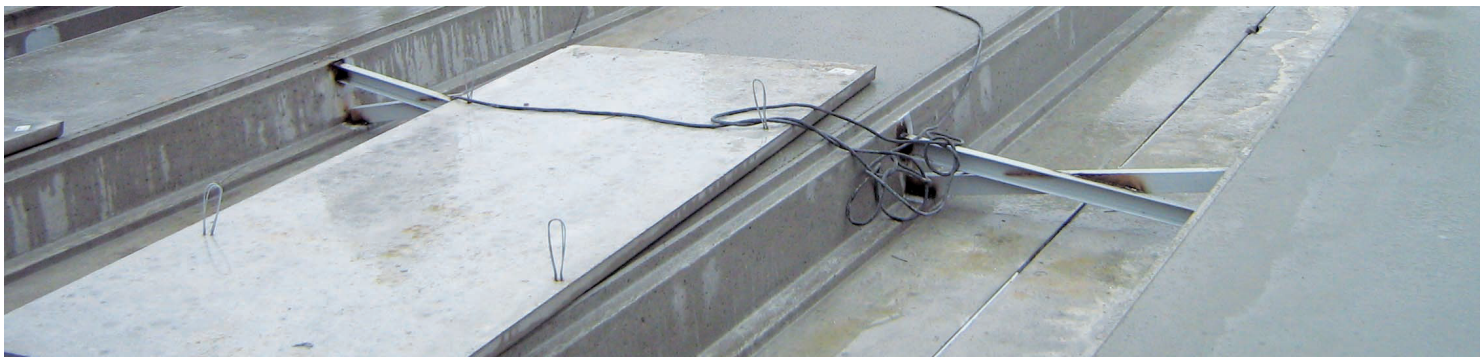
Solaio assemblato a secco con traverso centrale di irrigidimento e vani per il passaggio dell'impiantistica
