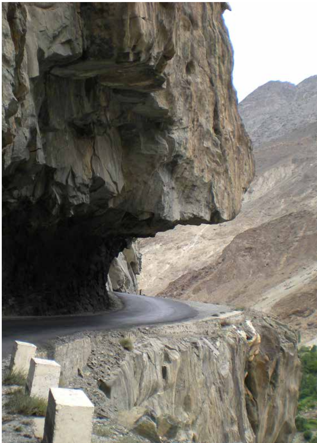
Un tratto scavato nella roccia della strada che collega Gilgit a Skardu
