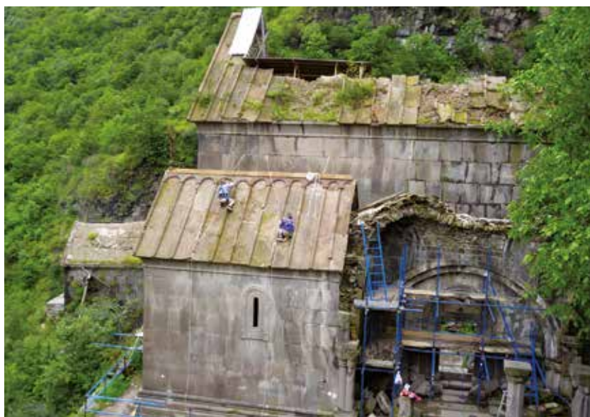
Creazione della linea vita e restauro delle coperture della piccola cappella di Kobayr Creation of the lifeline and restoration of the roof and on the chapel in Kobayr
