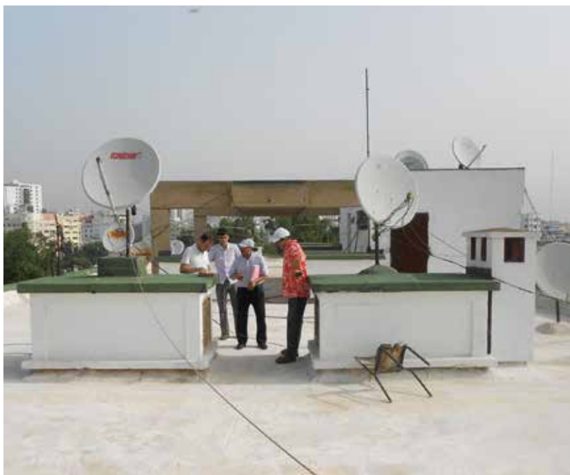
Tetto piano tipico per l'installazione di impianti solari termici nell'ospedale di Casablanca Typical flat roof for installation of solar water heaters at Casablanca hospital
