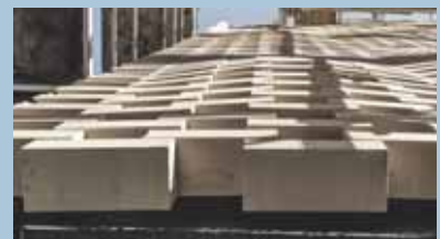
Fase di montaggio in cantiere.
