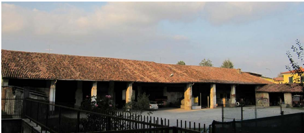
Figura 14. Brescia, cascina Castelvovati. L'elevato numero di capi di bestiame da ricoverare ha reso necessaria la realizzazione di una struttura di modesta altezza, ma molto sviluppata in lunghezza (foto V. Gambassa).
