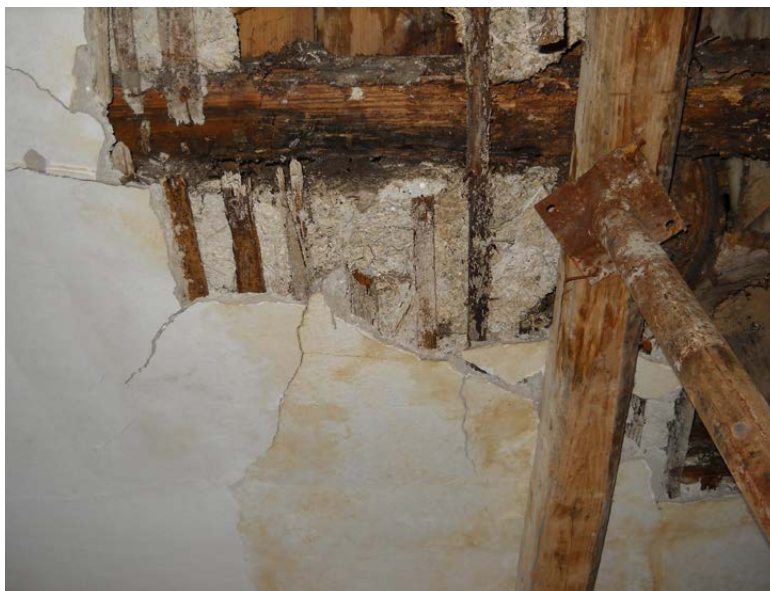
Figura 33. Gardone, Brescia, controsoffitto in arelle (foto A. Fontanini).
