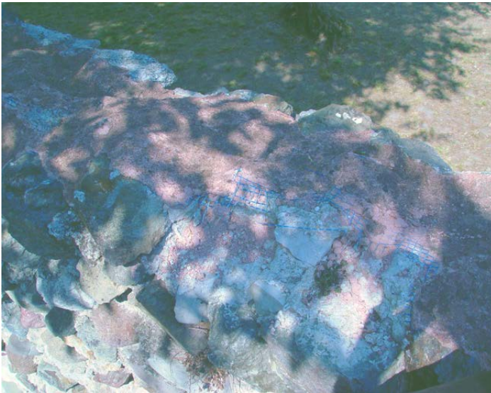
Figura 44. Puegnago del Garda, Brescia, stato di conservazione della copertina in cocciopesto dopo cinque anni dalla stesura (foto B. Scala).
