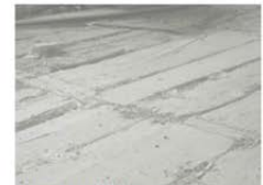
Particolare del tavolato del solaio del porticato.
