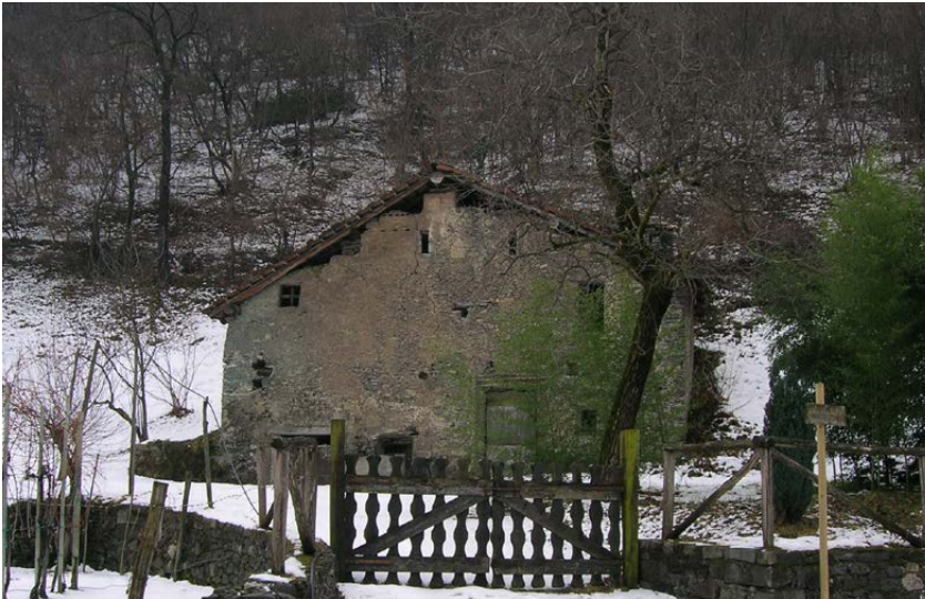
Figura 1. Cividate, Brescia, cascina Fratelli Gozio. È evidente come la cascina risponda alle esigenze di protezione dal freddo: le finestre piccole, la posizione riparata dalla montagna e dal bosco retrostante (foto B. Scala).
