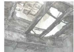
Particolare del solaio di un ambiente interno a doppia orditura.
