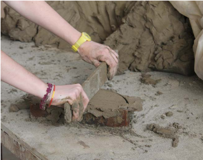
Figura 39. Preparazione di mattoni in terra cruda (foto B. Scala).
