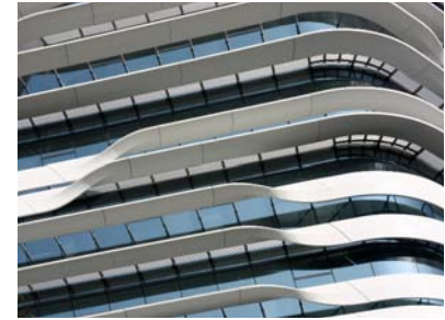
Fig. 6 Zaha Hadid. Le schermature solari sono costituite da elementi orizzontali in parte a ridosso della superficie vetrata e in parte vincolate alla struttura di facciata ma in aggetto. La variazione di posizionamento e la variazione di forma generano, a parità di orientamento, una variazione di apporti solari gratuiti Fonte: G. Masera
