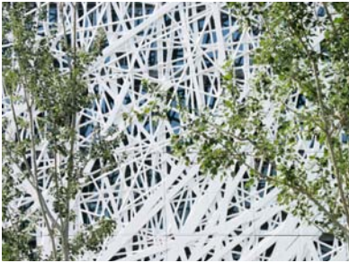
Fig. 4 Palazzo Italia EXPO2015. La seconda pelle in calcestruzzo armato. Ogni pannello è diverso dall'altro per forma e per rapporto di vuoto su pieno (% foratura). Questo è stato possibile grazie alla perfezione e al grado di precisione ottenibile impiegando il cemento biodinamico, unitamente all'impiego di strumenti di progettazione parametrica Fonte: G. Masera
