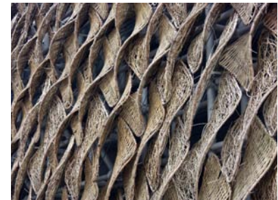
Fig. 9 Padiglione Spagnolo per Expo Shanghai 2010, Enric Miralles, Benedetta Tagliabue - EMBT. In questo progetto la complessità della schermatura solare è evidente: differenti forme anche a doppia curvatura, elementi con differenti giaciture, diverso rapporto vuoto su pieno e differenti forme di campitura Fonte: G. Masera
