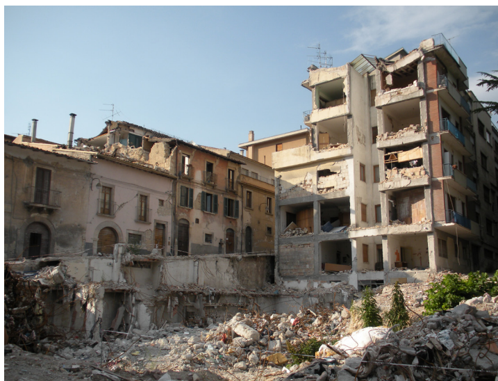
Fig. 4. L'Aquila, crollo di edifici in c.a. in via Campo di Fossa, ove gli edifici storici, pur danneggiati, hanno resistito al sisma (foto C. Bartolomucci 2009).
