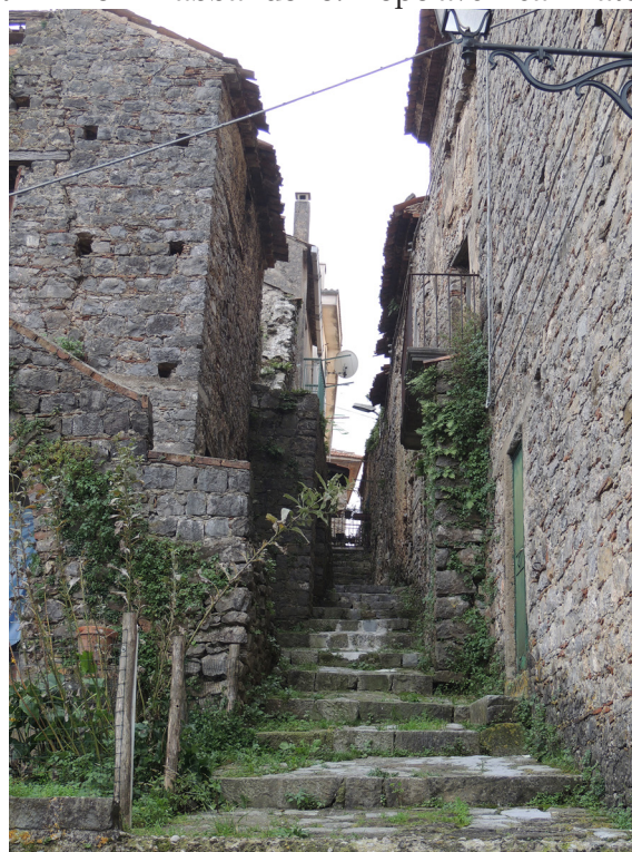
Fig. 4. Apice (BN). Il paese, abbandonato dagli anni Sessanta del Novecento a causa di eventi franosi, è ancora in attesa di un programma di restauro (2004).
