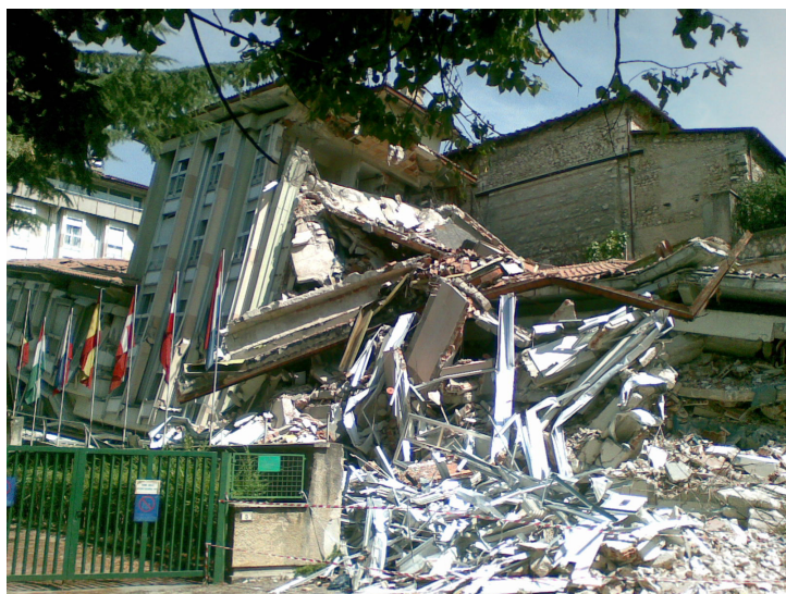
Fig. 3. L'Aquila, rovine di costruzioni moderne: l'Hotel Duca degli Abruzzi e, dietro di esso, la chiesa dell'Addolorata pressoché intatta (foto C. Bartolomucci 2009).
