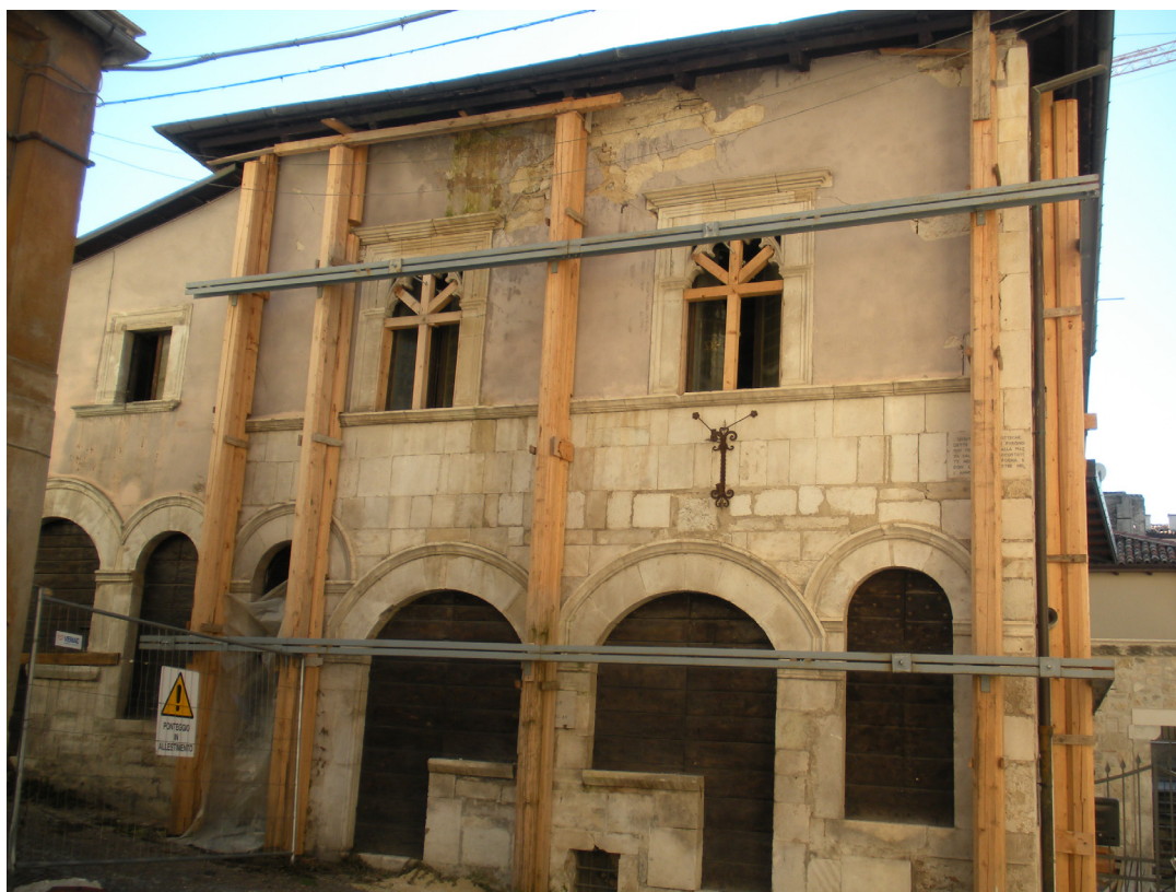
Fig. 1. L'Aquila, a sx: Le Cancele, il caso più noto – ma non l'unico – di edificio abbattuto nel 1919 e ricostruito altrove ricomponendo gli elementi formali provenienti dalla demolizione (foto C. Bartolomucci 2010).
