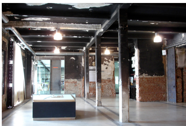
Fig. 5. Matadero, Madrid. Vista generale (foto N. Sulfaro).
