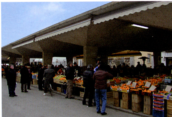
La pensilina dell'area mercatale prima dell'intervento di conservazione.
