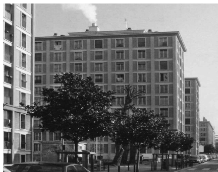
2. Quartiere a Pantin, F. Pouillon, 1955-57. DRAC Ile-de-France.
