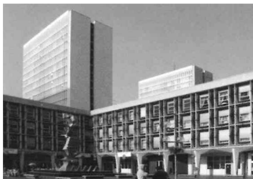
3. Il Grand Ensemble Les Flanades, Sarcelles, R. Boileau e J. Labourdette, 1955-72. DRAC Ile-de-France.
